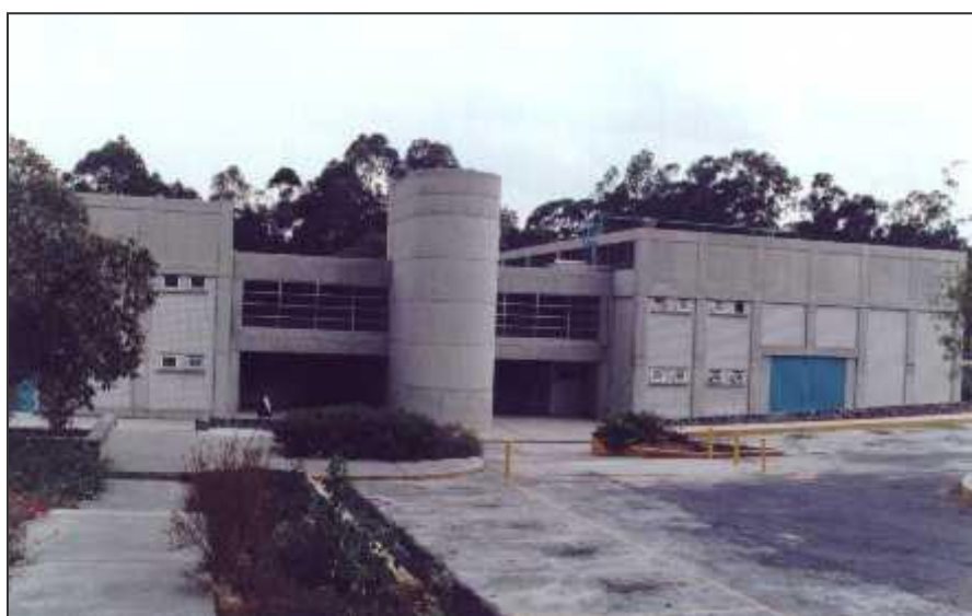
Figura I.1. Laboratorio de Control de Emisiones.
