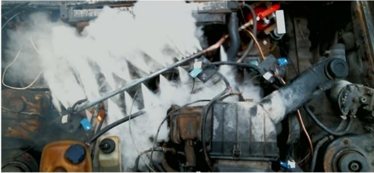
Figura 66. Activación del sistema de contención.
