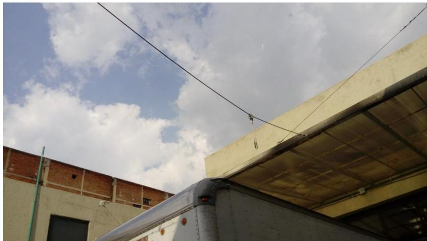
En la instalación de línea de vida se incluyo una extensión para colgar el estrobo, cuando se trabaje en rampa y así se compensa la altura que falta para poderse enganchar a causa de la inclinación de la misma.
