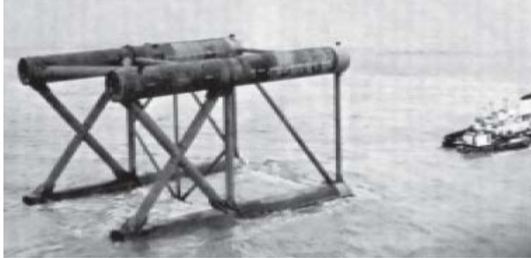
**Figura 1.10 Subestructura para una plataforma tipo torre**
