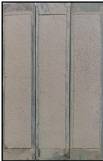
Figura 48: Contracción Lineal de la Cantera Cerro Jardín. (Fuente: Lab. de Agregados CEMEX)
