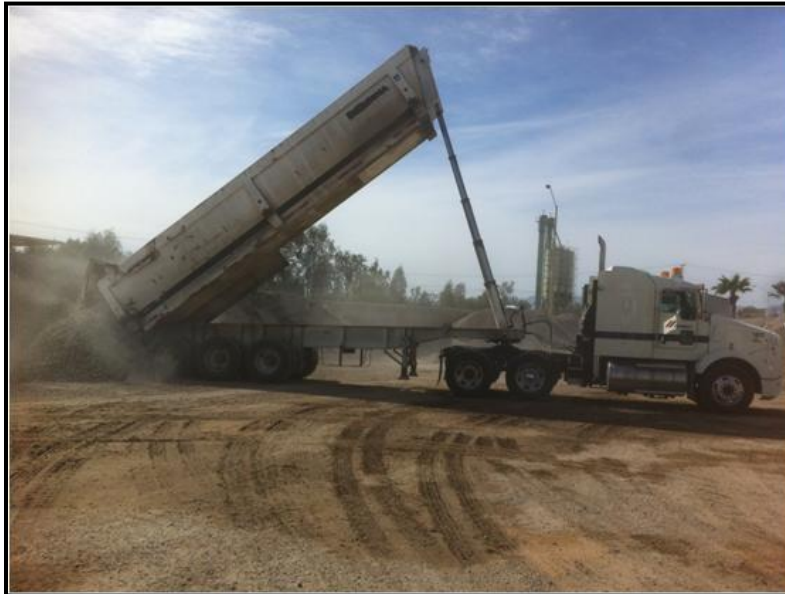
Figura 25: Góndola de agregados descargando material en planta. (Fuente: Cantera CMX CJ)
