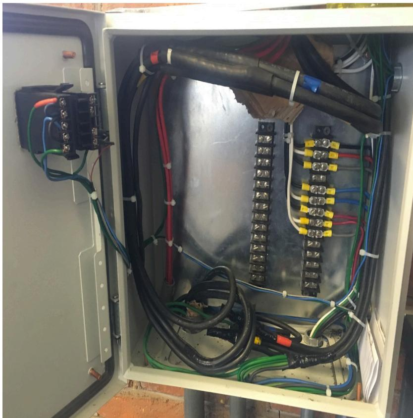
**Fig. 43** PLC conectado al sensor de temperatura y extractor de aire
