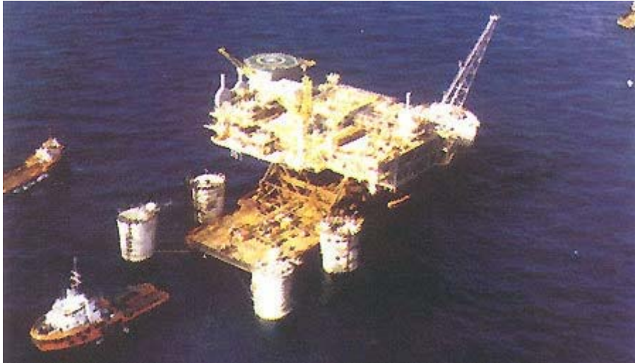
Instalación de la cubierta de la plataforma Malampaya
