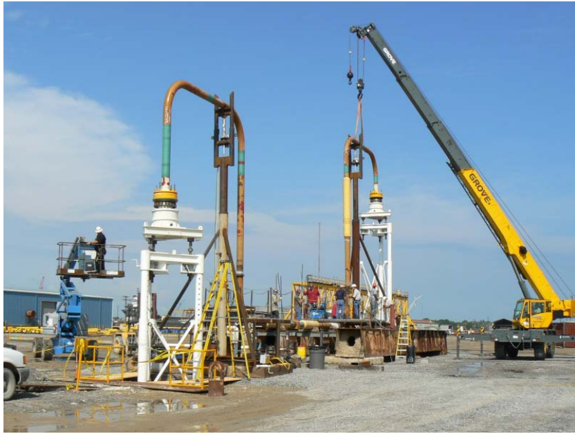
Jumper con forma de "M".
