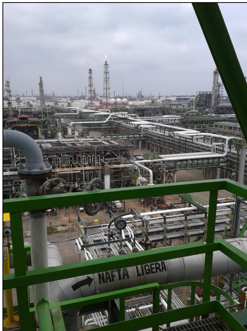
Figura 1.5. Línea con aislamiento de Nafta ligera (HDNC).
