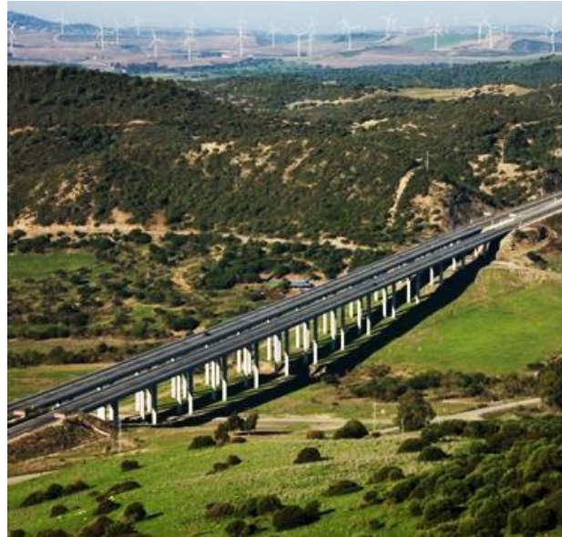
Fig. 4-30 Viaducto cuyo soporte son columnas delgadas que procuran invadir al mínimo el terreno natural.
