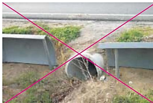
Fig. 4-66 Ejemplo 2 de malas prácticas: Desajuste de la estructura guía y el acceso al paso para anfibios. Foto:
