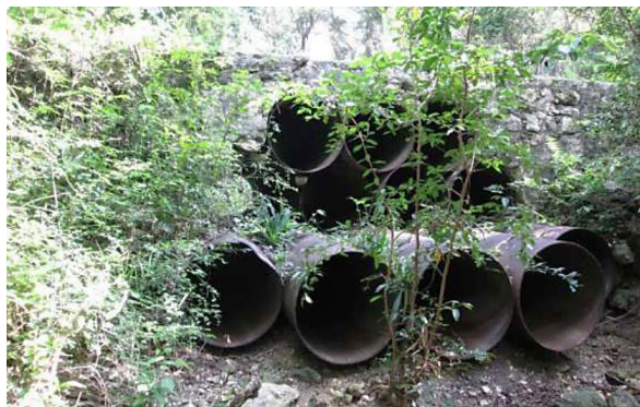
Fig. 5-12 Ejemplo de obra de drenaje conformada por 12 tubos, ubicada en el km 58+093 que podría ser reemplazada por una losa para facilitar el tránsito de fauna de talla inferior-mediana. Foto: Ref.16
