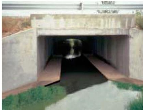
Fig. 4-51 Ejemplo de drenaje adaptado para paso de fauna. Nótese la comunicación de las plataformas con las rampas de acceso. Foto: C. Rosell.
