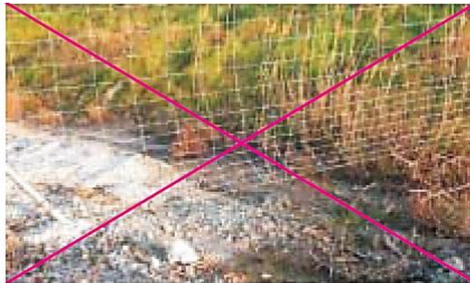
Fig. 4-15 Un ejemplo de lo que no se debe de hacer . La malla no está enterrada, por lo que algunas especies pueden evadirla pasando por debajo de ella. Foto: F. Navàs.
