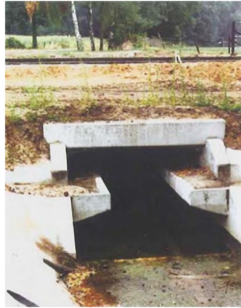
Fig. 4-46 Drenaje prefabricado en la Autopista A35 en Holanda, con plataformas laterales integradas que son utilizadas para el paso de pequeños animales. Foto: G. Veenbaas.
