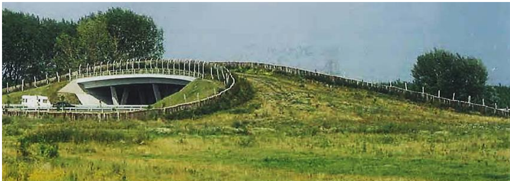
Fig. 4-22 Paso situado en un terreno llano, con rampas de ligera pendiente. Foto: P. Farkas.
