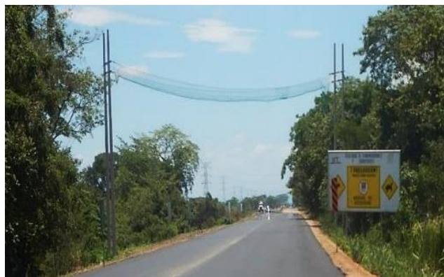
Fig. 5-4 Paso aéreo y señalamiento dentro del proyecto de ampliación de la carretera "Villahermosa-Escárcega".
