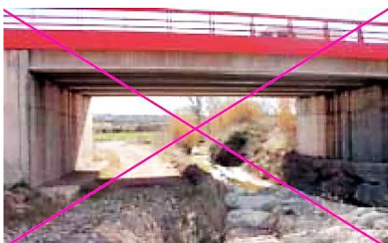
Fig. 4-39 Ejemplo de malas prácticas: En este caso la escollera dificulta el paso de fauna. Foto: F. Navàs.
