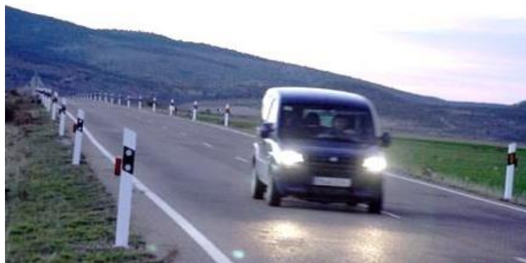
Fig. 4-6 Reflectores instalados en carreteras de Aragón, España.
