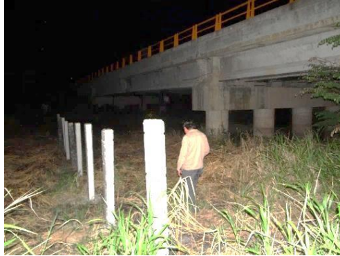
Fig. 5-2 Monitoreo de pasos subviales tipo viaducto adaptado.
