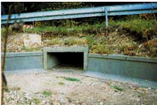
Fig. 4-67 El terreno adyacente a la estructura guía se mantiene completamente liso y libre de vegetación.
