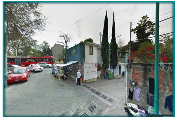
FOTOGRAFÍA 6 VISTA HACIA EL ACCESO ACTUAL DEL PREDIO SOBRE LA CALLE CALLEJÓN SAN MARCOS DIRECCIÓN NORTE - SUR
