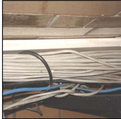
FOTOS 4.20 Y 4.21 CABLEADO DEL LABORATORIO 2 SIN CANALETA
