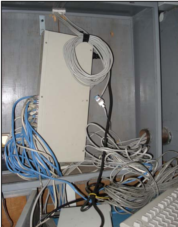
FOTO 4.15 HUB DE 24 NODOS PARA EL LABORATORIO 1
