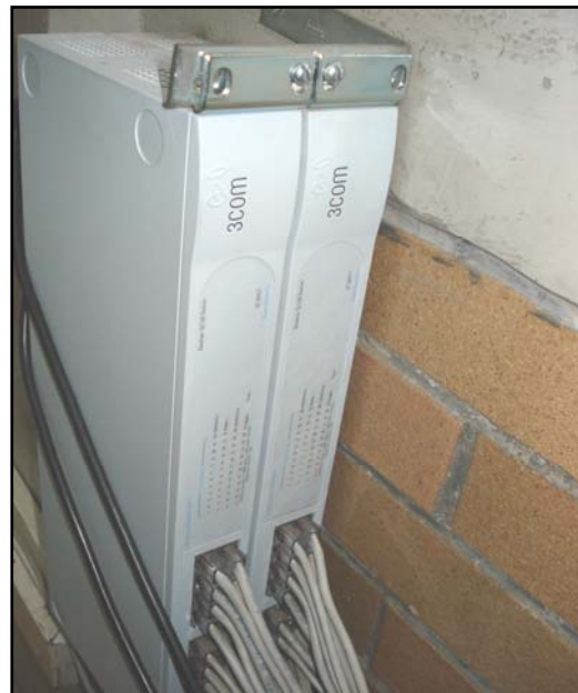
FOTOS 4.18 Y 4.19 SWITCHES 2X24 PARA EL LABORATORIO 2
