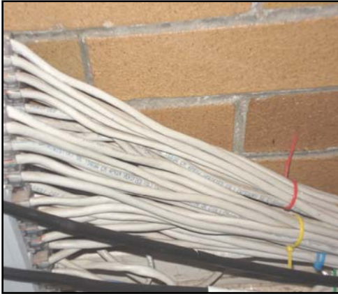
FOTOS 4.20 Y 4.21 CABLEADO DEL LABORATORIO 2 SIN CANALETA
