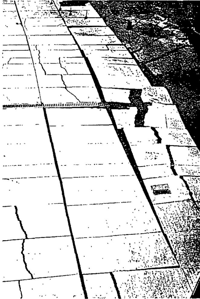
*"Deformaciones y desplazamiento lateral de losas de concreto"*
