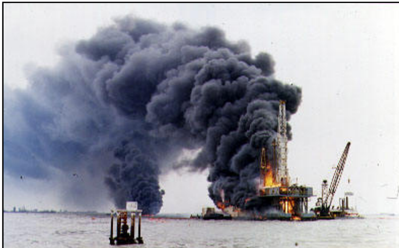
Figura 1-3. Siniestro de un descontrol de pozos en plataforma.
