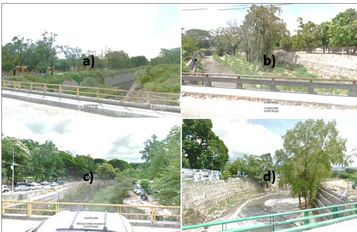
Figura 6.5. Revestimiento de los márgenes con muro gavión: a) puente casa Kolping, b) 20 ote. Norte, c) 11ª calle norte y d) libramiento norte a un costado de procuraduría.
