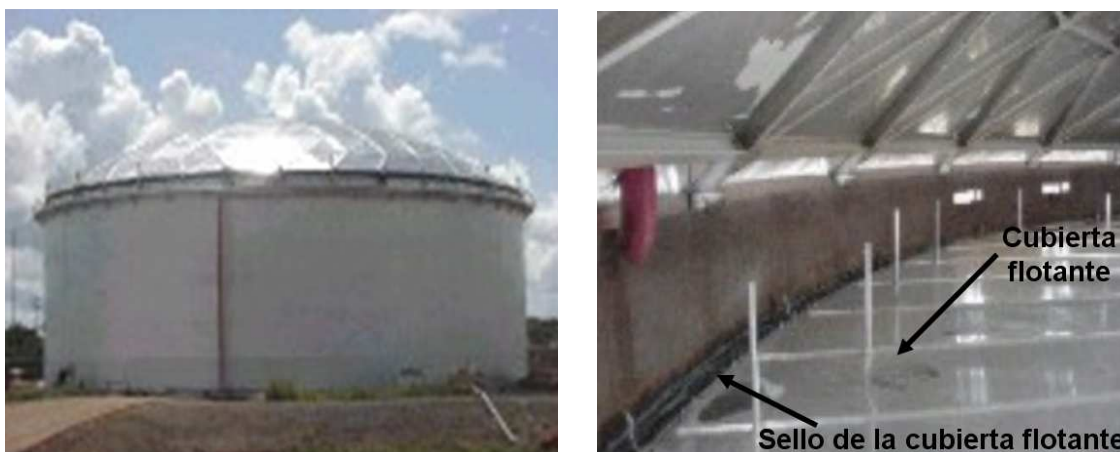
Figura 7.5 Tanque con domo geodésico, (Oñate, E., 1992).
