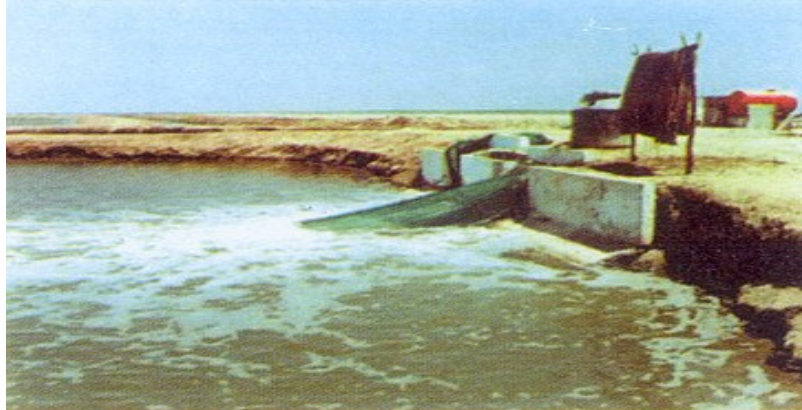
Foto 3.4. Salida al canal de alimentación.
