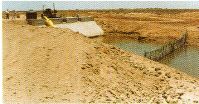
Foto 2.1. En esta fotografía se puede observar el tipo de malla sostenida por tres palos y el deterioro de la misma en el canal de llamada de una de las granjas en el estado de Sinaloa.
