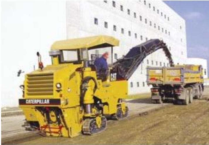
Dentro de las nuevas técnicas para la rehabilitación de los pavimentos de concreto asfáltico, actualmente se está empleando el sistema de “fresado y sobrecarpeta”, que en términos generales consiste en lo siguiente:
