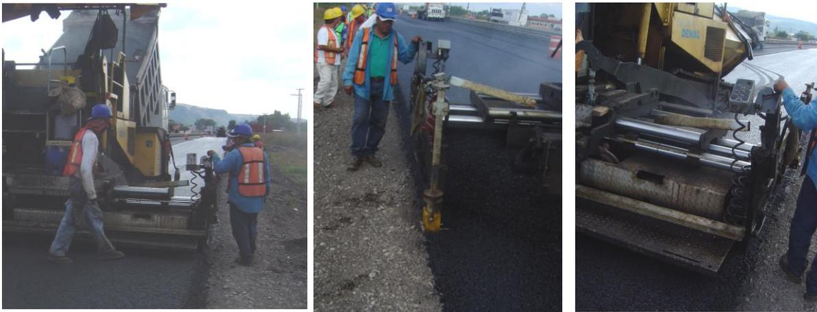
Puesto que estas referencias ayudan a controlar el nivel del pavimento asfáltico, son conocidos como “los sistemas de la referencia del espesor” y se enumeran a continuación:
