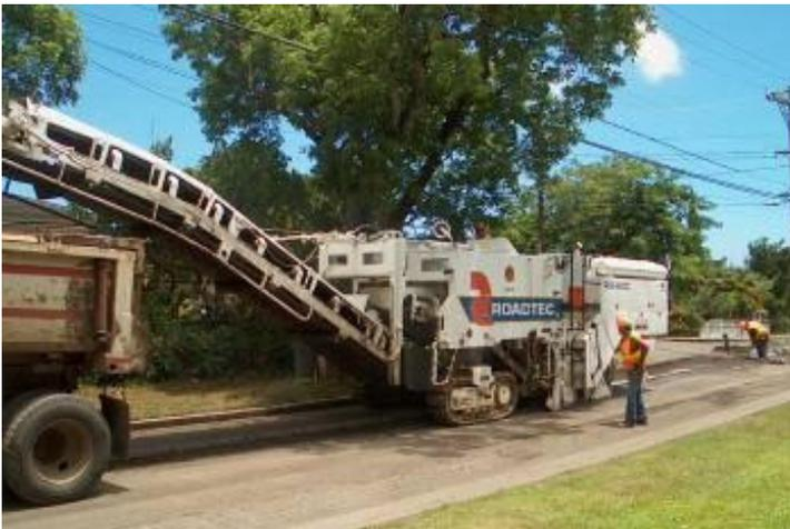
El fresado puede reducir o hasta eliminar los problemas de agrietamientos
