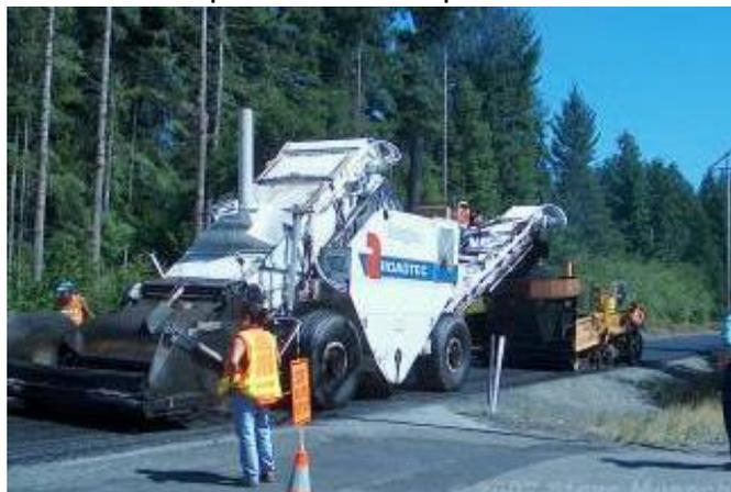
La pérdida de temperatura es un factor importante y ocurre durante el transporte porque el concreto asfáltico en la superficie de la caja del camión se refresca mientras que la mezcla en el centro conserva calor. El nivel del pavimentador es sensible a la rigidez de la mezcla, que está en gran parte en función de la temperatura.
