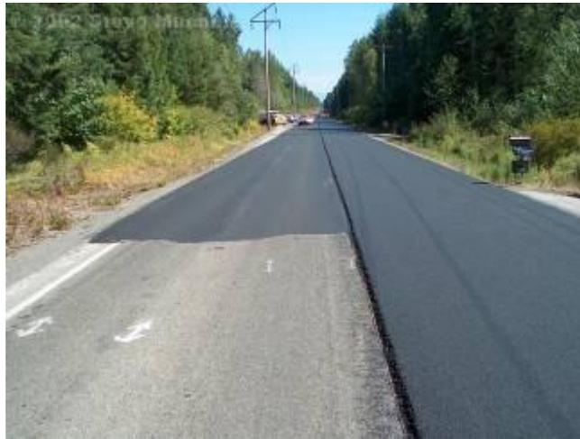
La velocidad del pavimentador se liga a la cantidad en la cual la mezcla del asfalto se entrega de la planta. Para producir una carpeta lisa, la velocidad de recorrido se debe mantener de manera constante. Los cambios en la velocidad del pavimentador son un factor que afectará el ángulo del ataque de los niveles. Además, cuando se detiene el pavimentador, los niveles se tienden para colocarse en la superficie de la carpeta.
