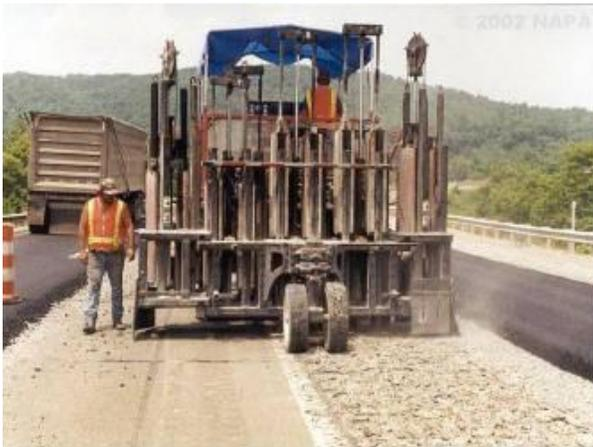
Este equipo utiliza una serie de martillos altos independientes controlados para romper la losa. Típicamente, esta equipado con entre 12 y 16 martillos, cada uno que pesa entre 450 - 680 kilogramos. Los martillos pueden caer de alturas variables (0.30 a 1.50 m.) y con ciclos con un índice de 30 - 35 impactos por minuto. El rendimiento de esta maquinaria proporciona poder trabajarla sobre un carril entero (hasta 50 m.) en una sola pasada.
