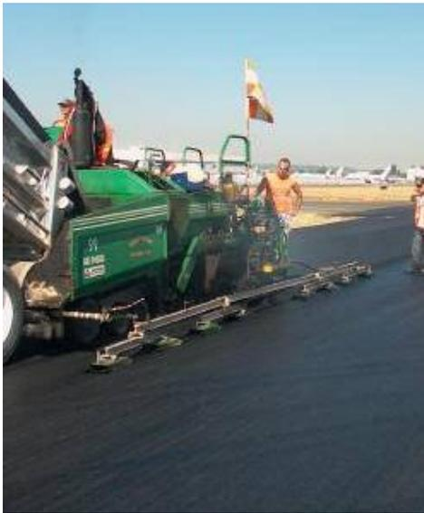
El sistema de la referencia móvil hace un promedio del efecto de desviaciones en la superficie existente del pavimento sobre una distancia mayor que la distancia entre ejes de la unidad del tractor. La longitud mínima del esquí para un dispositivo del contacto es normalmente cerca de 60 cm. cuando las longitudes típicas del esquí que están en la orden de 1.00 a 1.5 m.
