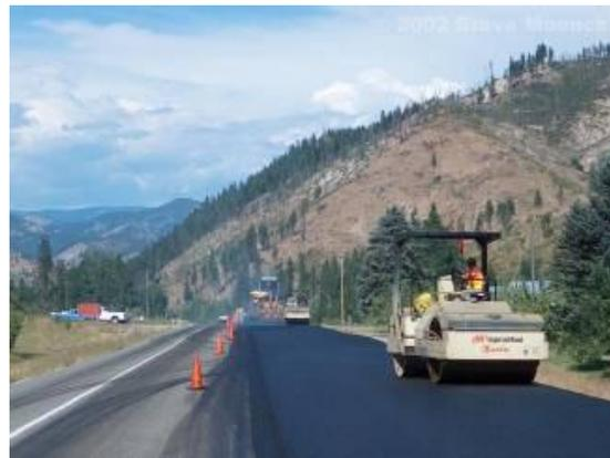
La compactación de la mezcla asfáltica se logra fácilmente cuando se lleva a cabo a la temperatura adecuada, ésta debe iniciarse tan pronto como sea posible después de la extendida de la mezcla.
