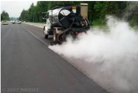
Esta ecuación se puede utilizar para estimar la cantidad de asfalto líquido requerida para un trabajo. Durante la construcción, la ecuación puede ser utilizada para comparar si el rendimiento del material es el verdadero. El gasto real del uso se compara con estos resultados y se pueden determinar especificaciones para el trabajo.
