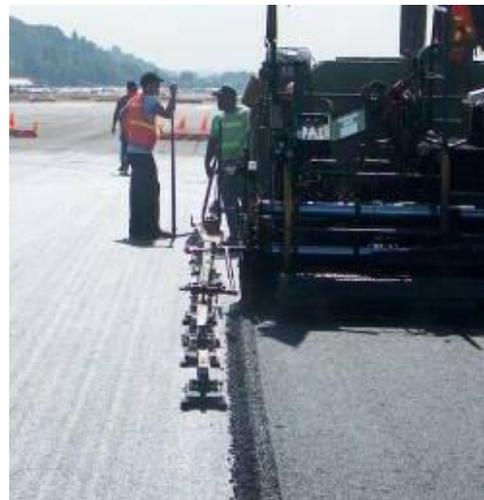
Los niveles de “flotación” están libres y son dispositivos que pueden girar sobre un perno. Este perno cuenta con un brazo que permite tener uno nivel uniforme y previene irregularidades en la superficie subyacente. La capacidad de nivelar irregularidades en el pavimento es controlada por la distancia entre los ejes del tractor y por la longitud entre los niveles en los brazos del remolque.
