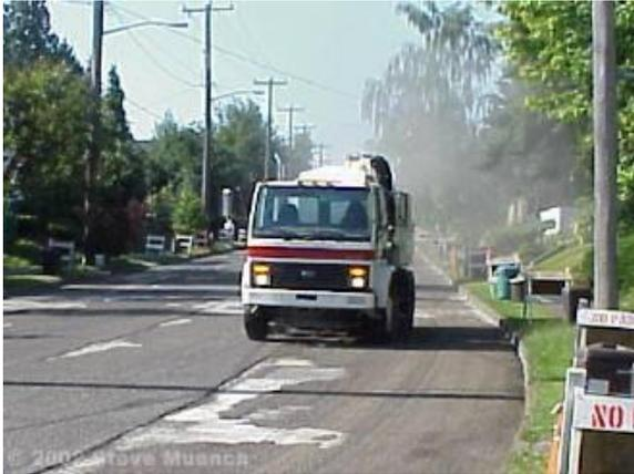
Cuando se va a realizar una repavimentación la barredora se utiliza para quitar el polvo de la superficie del pavimento existente antes de poner el asfalto nuevo, la capa del polvo debe ser totalmente retirada con la escoba de la barredora. Esto se hace para asegurar la adherencia apropiada entre el asfalto nuevo y el viejo pavimento.
