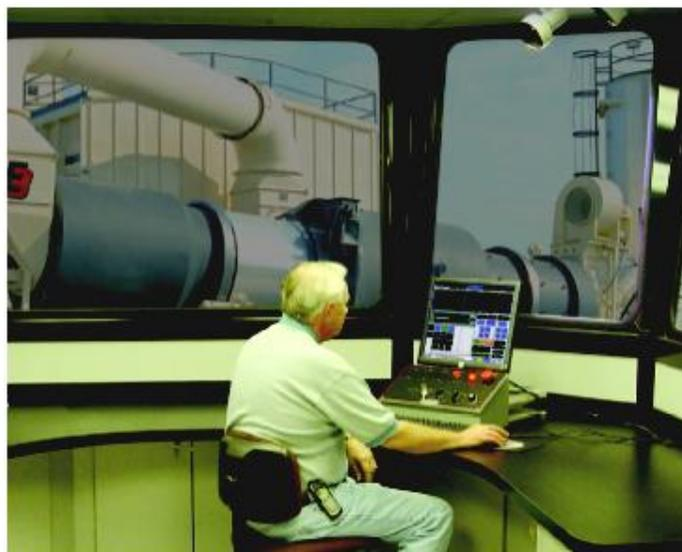
*Control de registro.* Permite al operador controlar el registro del ventilador de escape.
