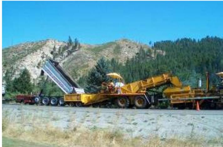
En este caso la sincronización de los camiones al sitio del trabajo no es crítica, puesto que el pavimentador puede funcionar desde el origen de material en el dispositivo de transferencia. El dispositivo de transferencia es independiente, así que el pavimentador no necesita acoplarse y empujar el carro del transporte como en el caso de la descarga directa de los camiones. Finalmente, remezclando el concreto asfáltico, se reduce la pérdida de temperatura.
