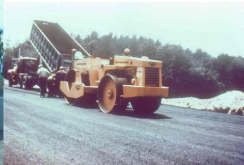
Estas máquinas se utilizan en operaciones con proyectos más pequeños y con un área limitada. Las demás operaciones se lleva a cabo de la misma forma que en el caso de descarga directa sobre la pavimentadora.
