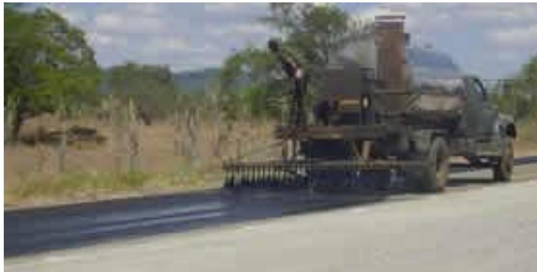
Los usos primarios de los cementos asfálticos están para las capas primeras de las capas de riego durante la construcción del pavimento, y como la carpeta para los cementos, los sellos de mezcla, y los materiales superficiales de la plantilla de la liga. Para la liga y las capas primeras y los tratamientos de la carpeta es aplicada rociando a través de un camión distribuidor.
