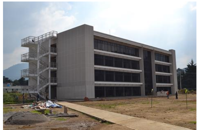
Figura III.15 Fachada norte y oriente
