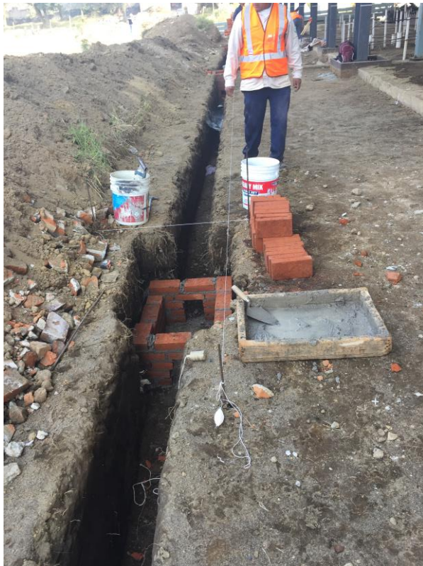
Figura III.51 Construcción de registro sanitario
