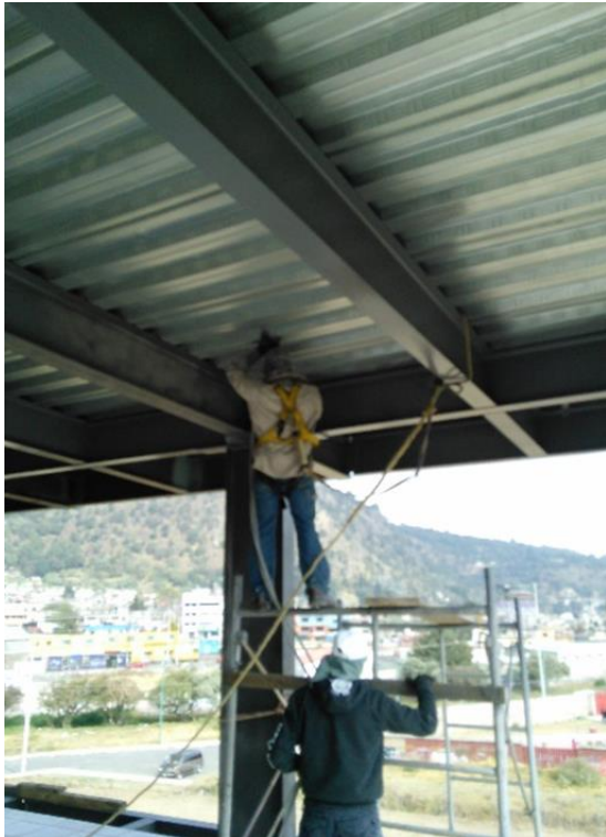
b) Aplicación de primario en estructura metálica
