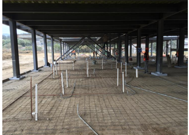
Figura III.37 Preparación de instalaciones eléctricas en planta baja
