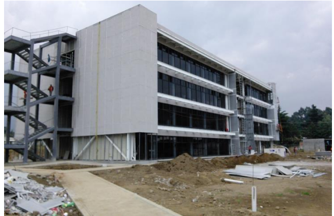
Figura III.77 Cristalería y cancelería de fachada oriente y cancelería en fachada norte.
