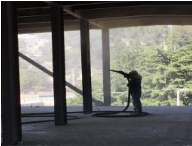
Figura III.47 Sandblasteo de estructura metálica.
