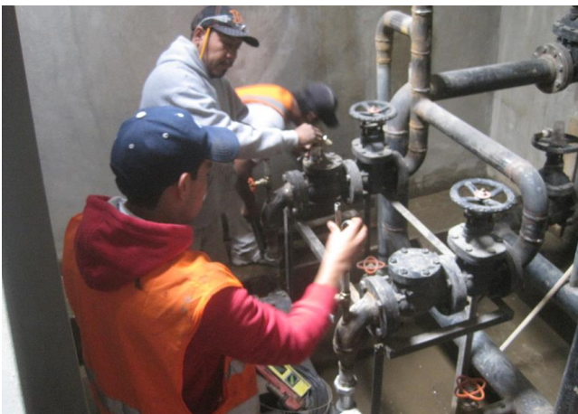
c) Instalación de válvulas y equipo hidroneumático
