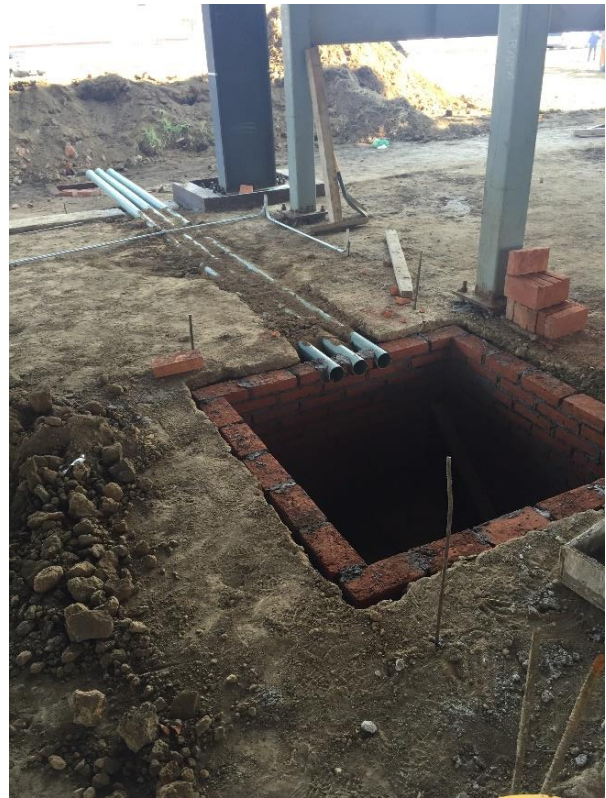
Figura III.52 Construcción de registro eléctrico
