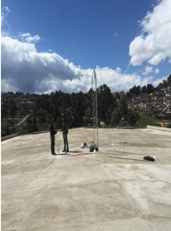
Figura III. 79 Montaje de punta de pararrayos en azotea
