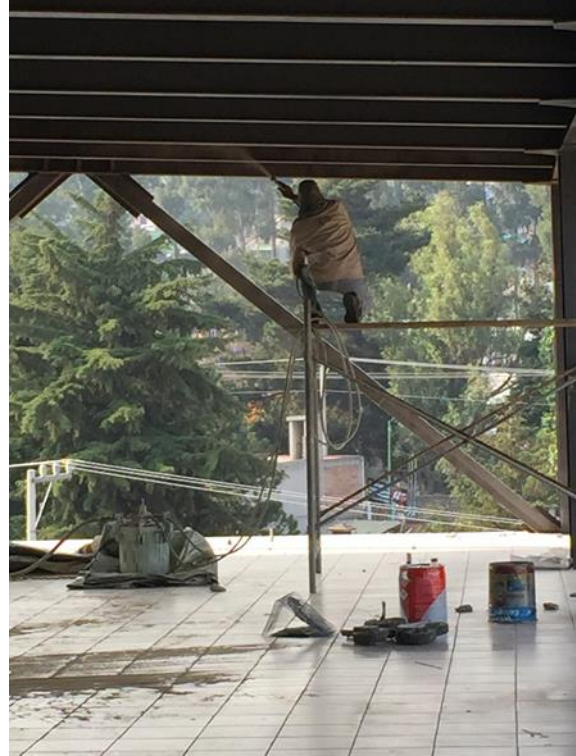
a) Limpieza de estructura metálica mediante sandblast.
