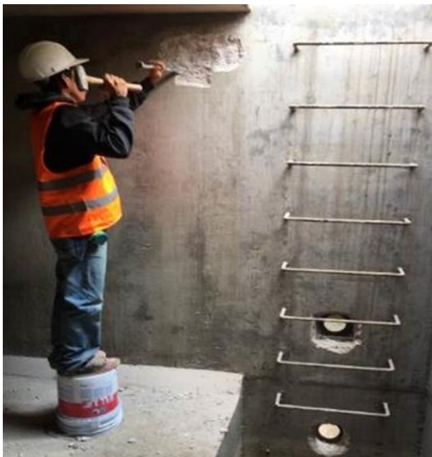
a) Escaleras provisionales del cuarto de máquinas
