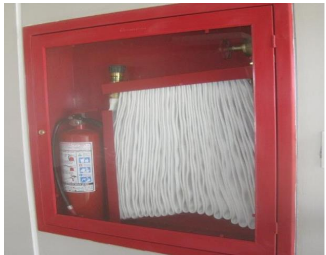
Figura III.31 Colocación de gabinete del sistema contra incendios.
