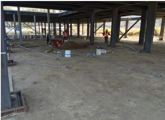
Figura III.37 Preparación de instalaciones eléctricas en planta baja
