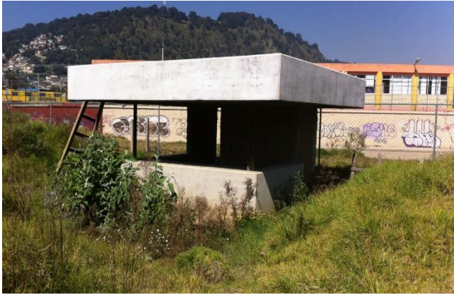
a) Caseta de vigilancia .
