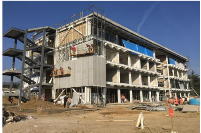
Figura III.75 Colocación de paneles de tablamento en fachada oriente.
