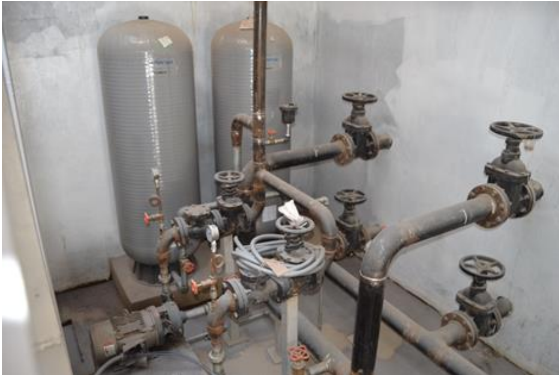
Figura III.23 Conexión y puesta en marcha de equipo hidroneumático en cuarto de máquinas.
