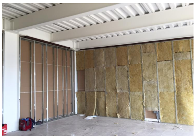
d) Colocación de fibra de vidrio aislante en muros de tablaroca.
