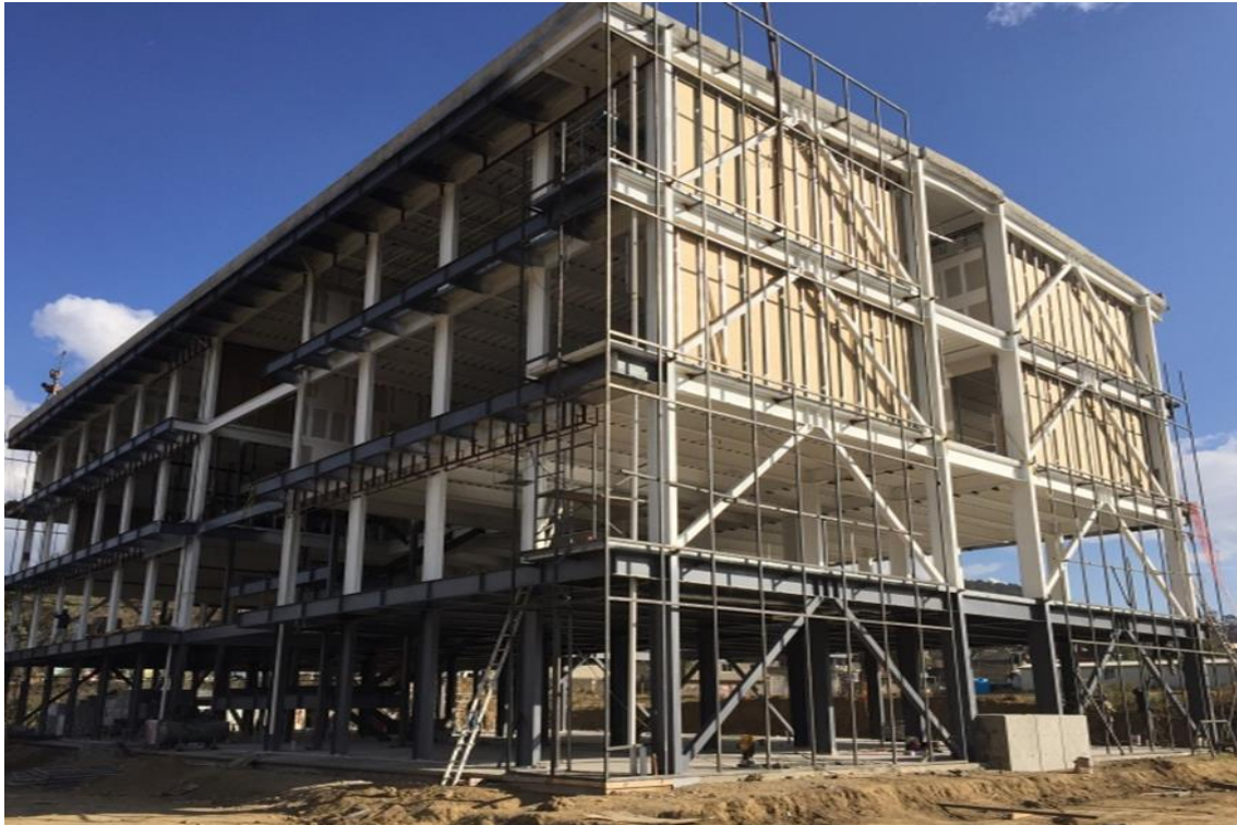
Figura III.61 Avance general de los trabajos del edificio.
