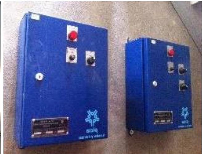
Figura III.33 Conexión y puesta en marcha de tableros de sistema contra incendios e hidroneumático.
