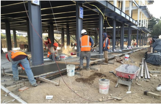
Figura III. 63 Colado de banquetas de andadores en exterior de edificio
