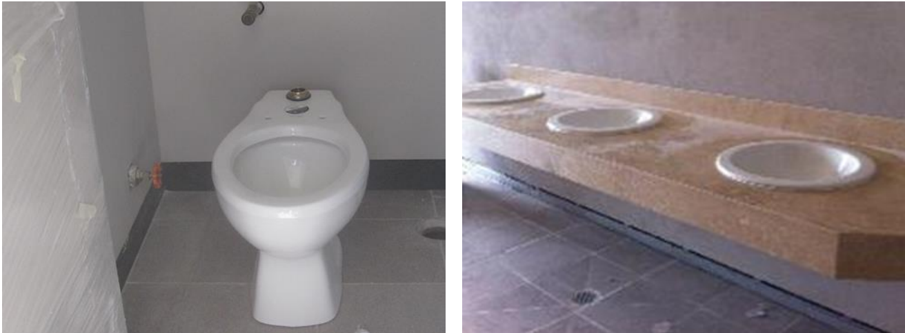
Figura III.27 Suministro y colocación de muebles de baño.
