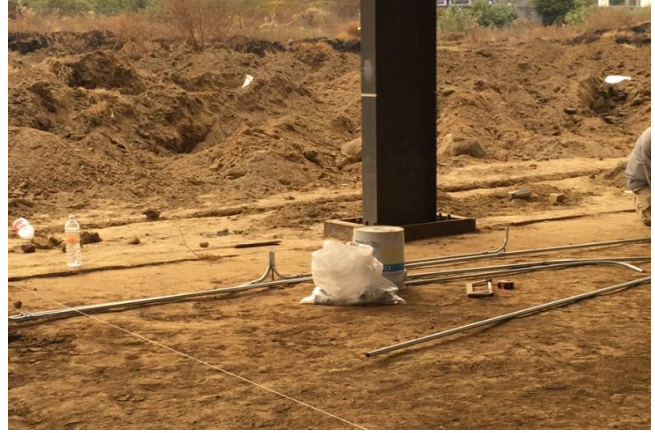
Figura III.54 Preparación de instalaciones eléctricas en planta baja
