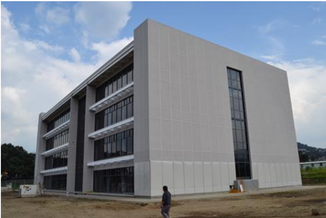
Figura III.81 Fachadas norte y poniente concluidas.
