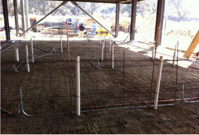
Figura III.53 Preparación de instalaciones hidrosanitarias en planta baja
