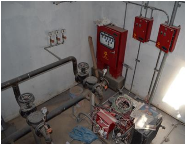
Figura III.33 Conexión y puesta en marcha de tableros de sistema contra incendios e hidroneumático.
