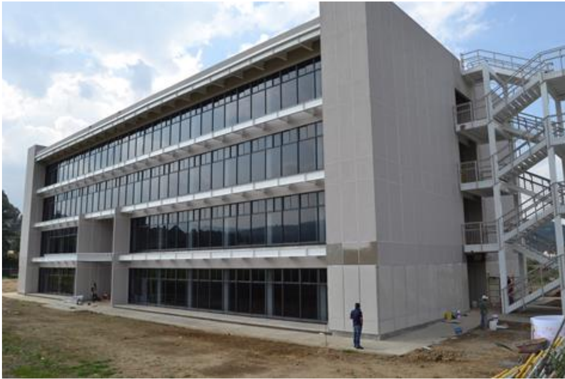
Figura III. 81 Fachadas sur, fachada oriente y escalera de emergencia concluidas.
