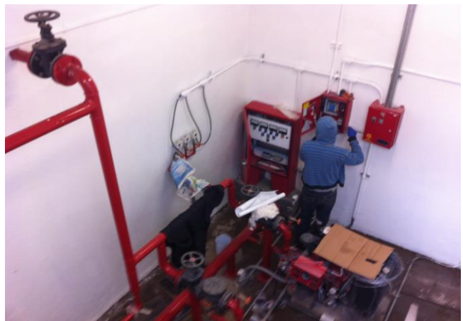
c) Instalación de válvulas y equipo hidroneumático
