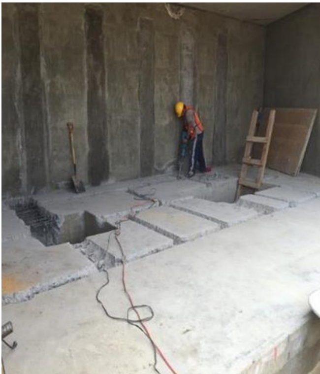
Figura III.65 Preparaciones a subestación para recibir equipos
