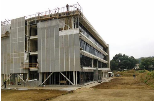
Figura II.77 Colocación de paneles de tablamento en fachada poniente
