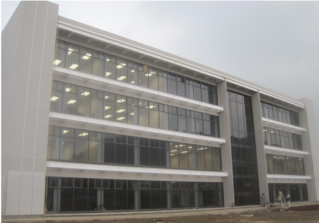
Figura III.40 Pruebas finales de iluminación dentro de edificio.
