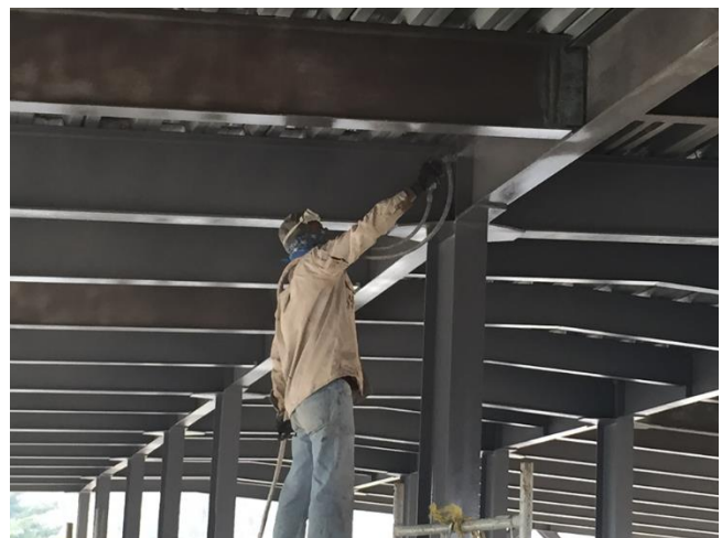
Figura III.48 Aplicación de primario en estructura metálica.
