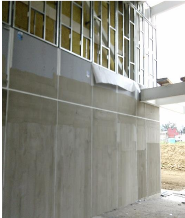
Figura III.56 Habilitado de muros de tablamiento en núcleo de escaleras.
