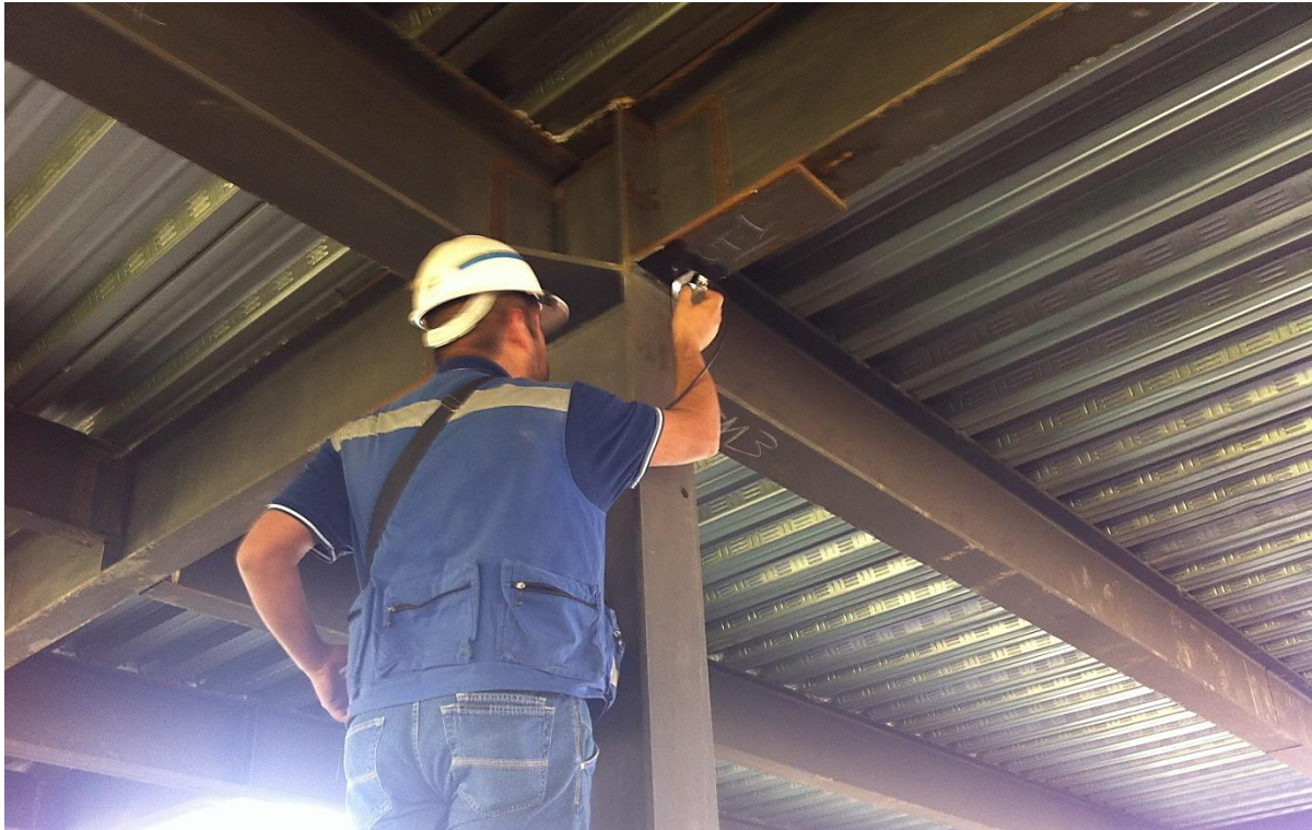
Figura III.46 Pruebas de líquidos penetrantes realizadas a la soldadura de estructura metálica.
