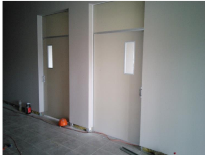
Figura III.70 Colocación de puertas en aulas
