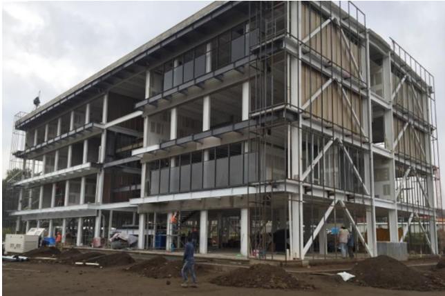
Figura III.74 Colocación de cancelería en fachadas. norte y poniente
