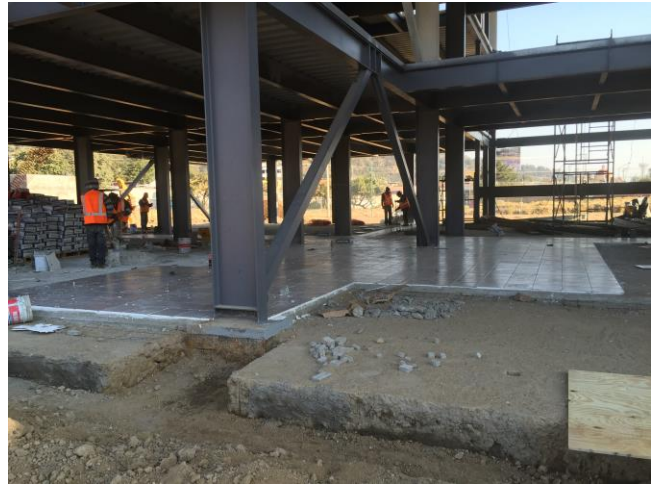
Figura III.50 Colocación de piso cerámico en planta baja.
