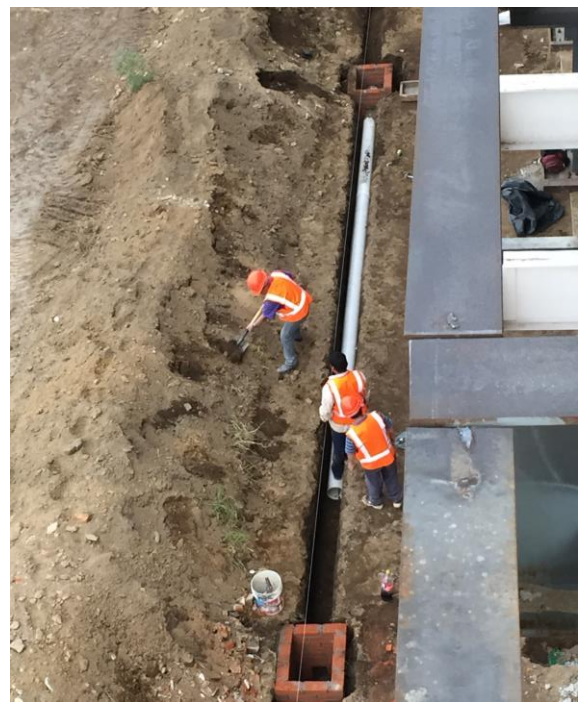
Figura III.26 Tendido de tubería para red sanitaria
