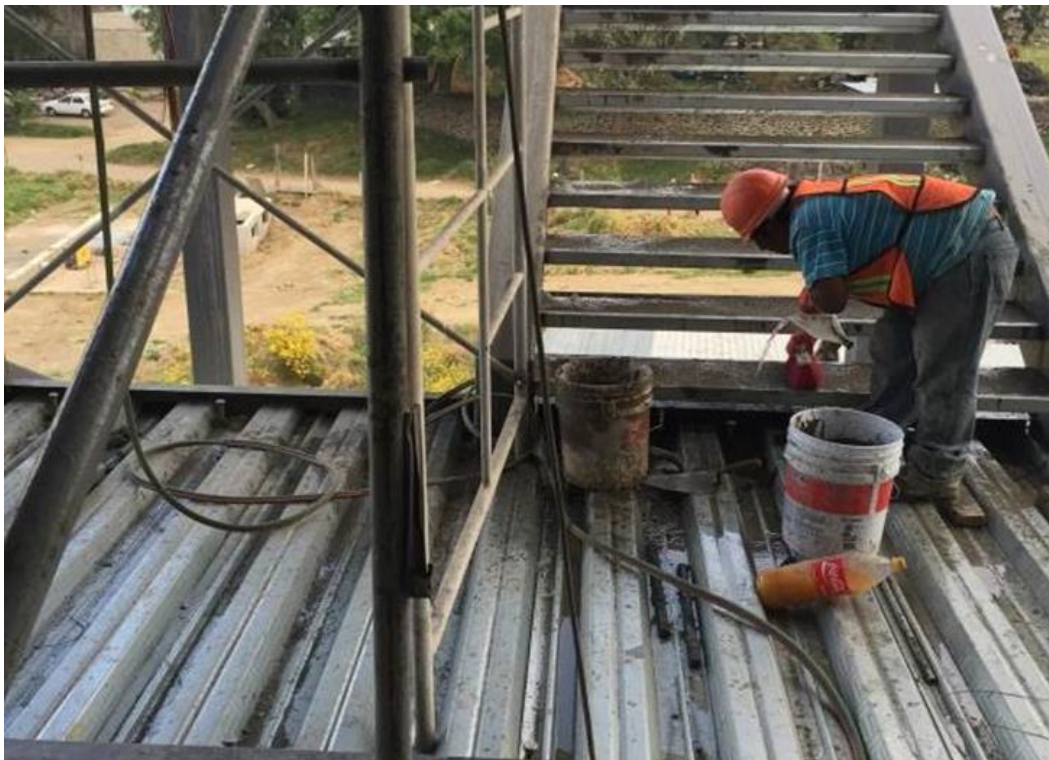
Figura III.60 Colado de escalones y descansos en escalera de emergencia.
