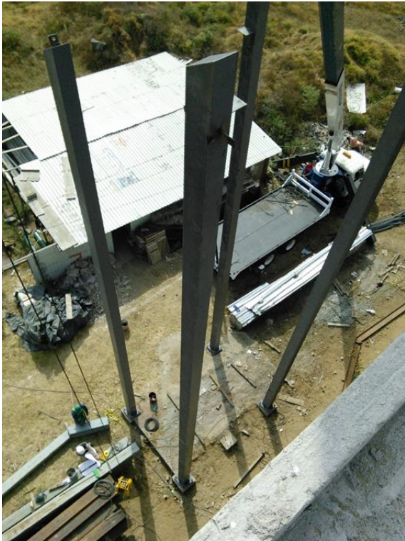
Figura III.59 Montaje de estructura metálica para la escalera de emergencia.
