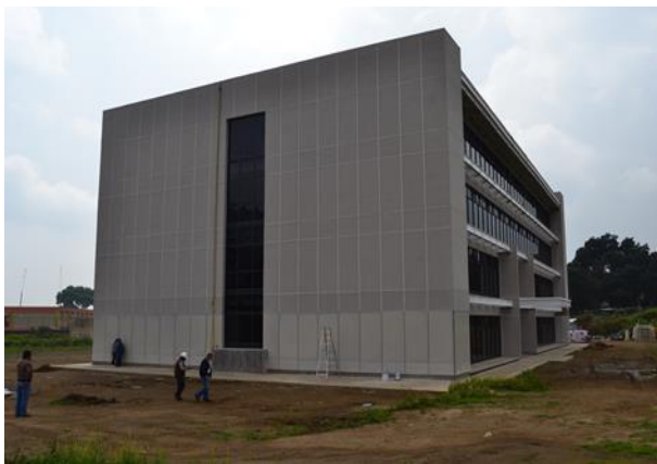
Figura III.14 Fachada sur y poniente
