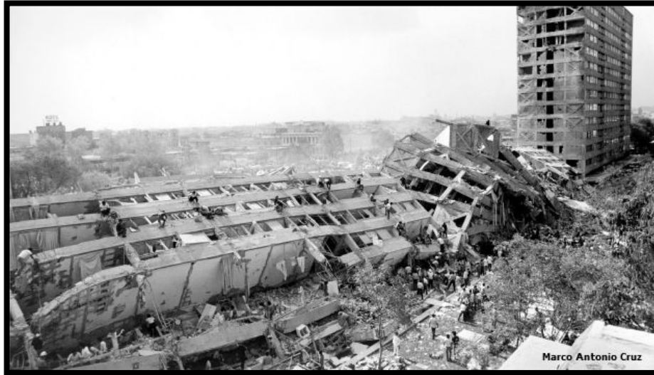
Figura 3. Daños ocurridos en la Ciudad de México el 19 de Septiembre de 1985.
