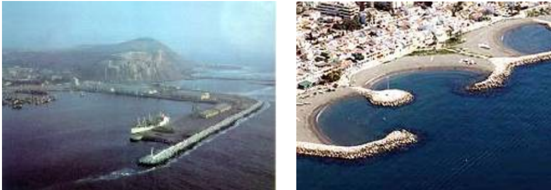
Figura II.6 Reflexión del oleaje debido a la presencia de rompeolas
