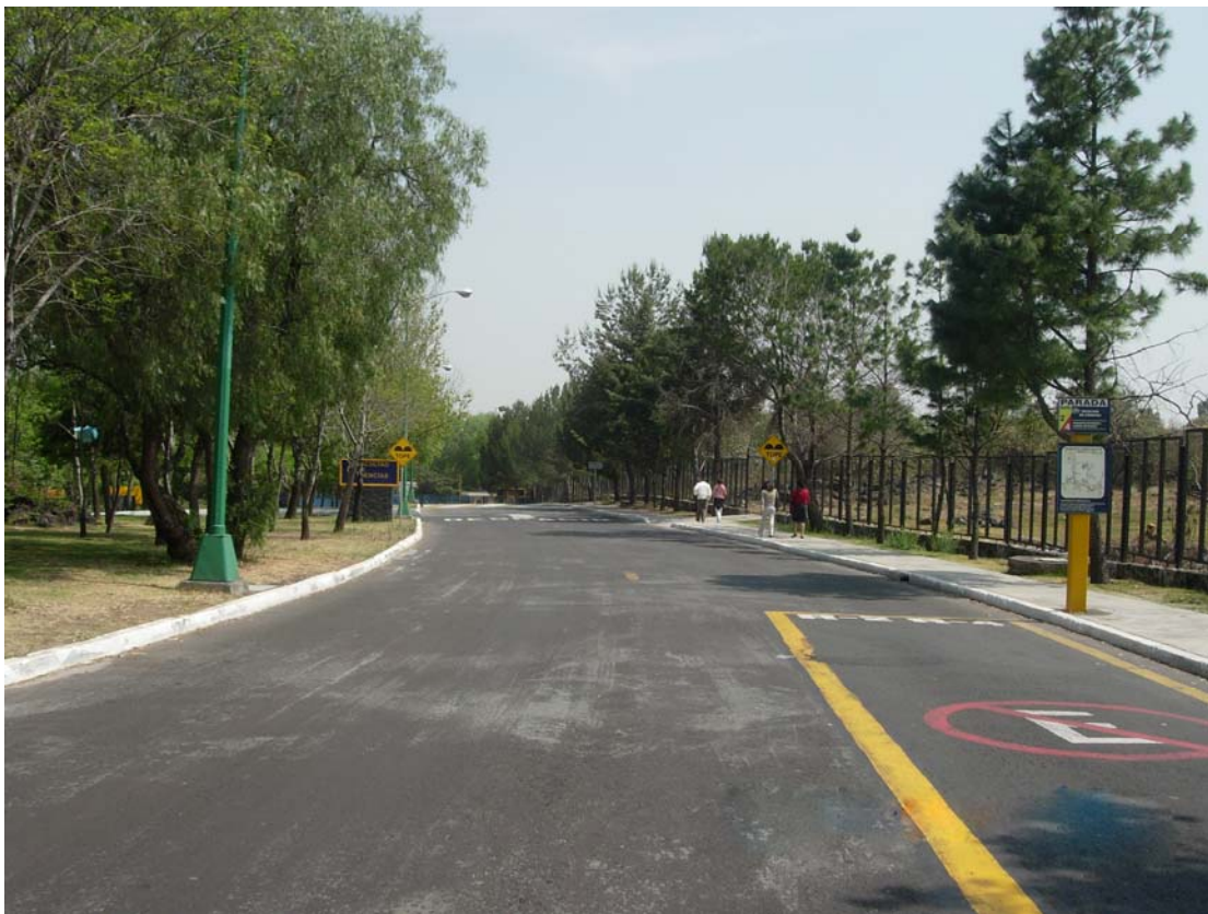
Imagen 1.1 Vista de una de las vialidades de CU con algunos dispositivos de control vehicular
