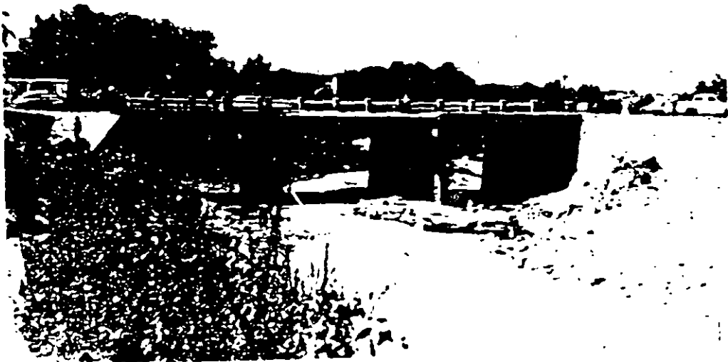
Puente con superestructura de concreto
