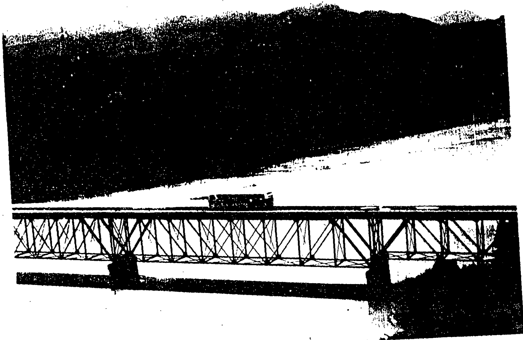
PUENTE "MEZCALA" Carretera: México - Acapulco
