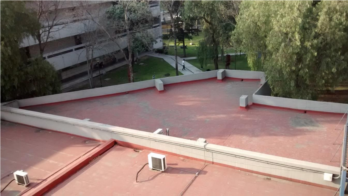
Figura 2.2. Vista desde la Torre del Edificio I
