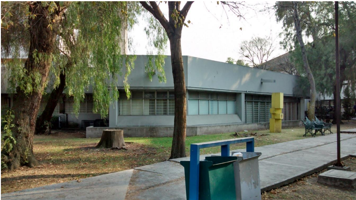
Figura 2.1. Fachada Norte de la edificación
