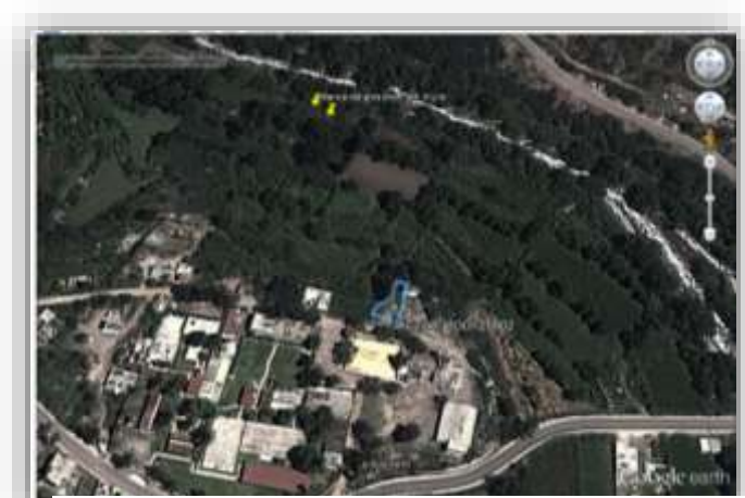
Ilustración 11. Vista aérea del terreno para la instalación de la planta de tratamiento de agua residual.
