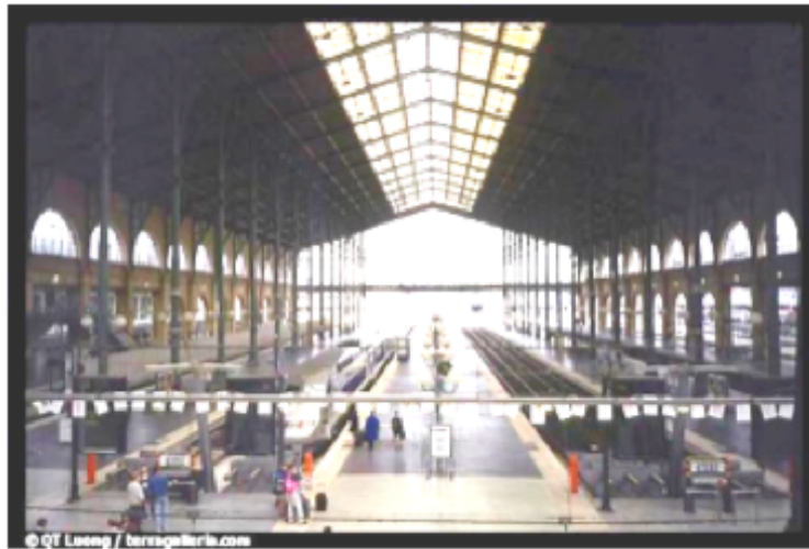
Figura 1.15 Vista interior de la Gare d'Austerlitz. Plataformas.
