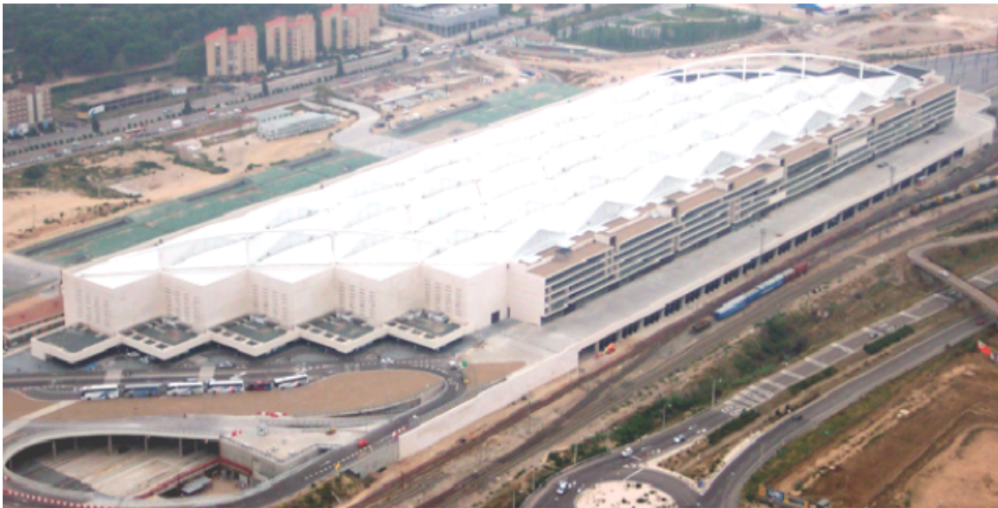
Figura 1.17 Vista exterior Estación Delicias
