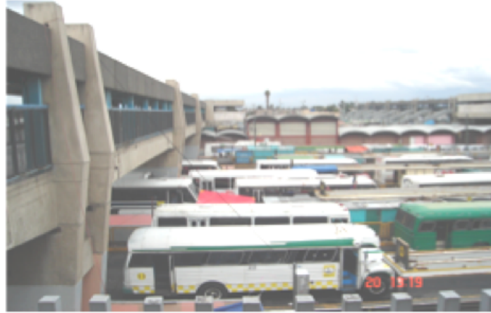
Figura 1.6 Problemáticas de saturación de bahías. CETRAM Pantitlán.
