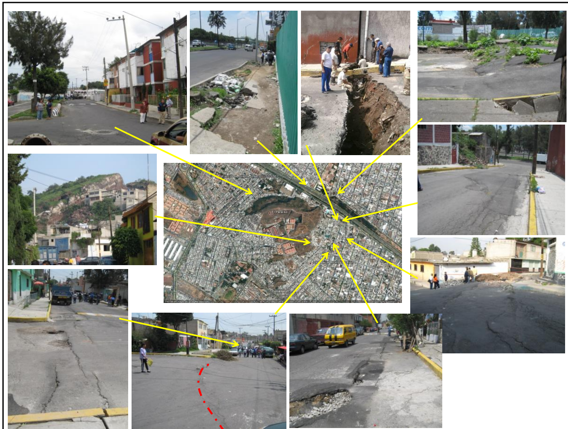
Figura 5.64.- Localización de los crecimientos dimensionales de las trazas del fracturamientos en el suelo, que afectan progresivamente a viviendas de las colonias circundantes al Peñón del Marqués en la Delegación Iztapalapa (2010).
