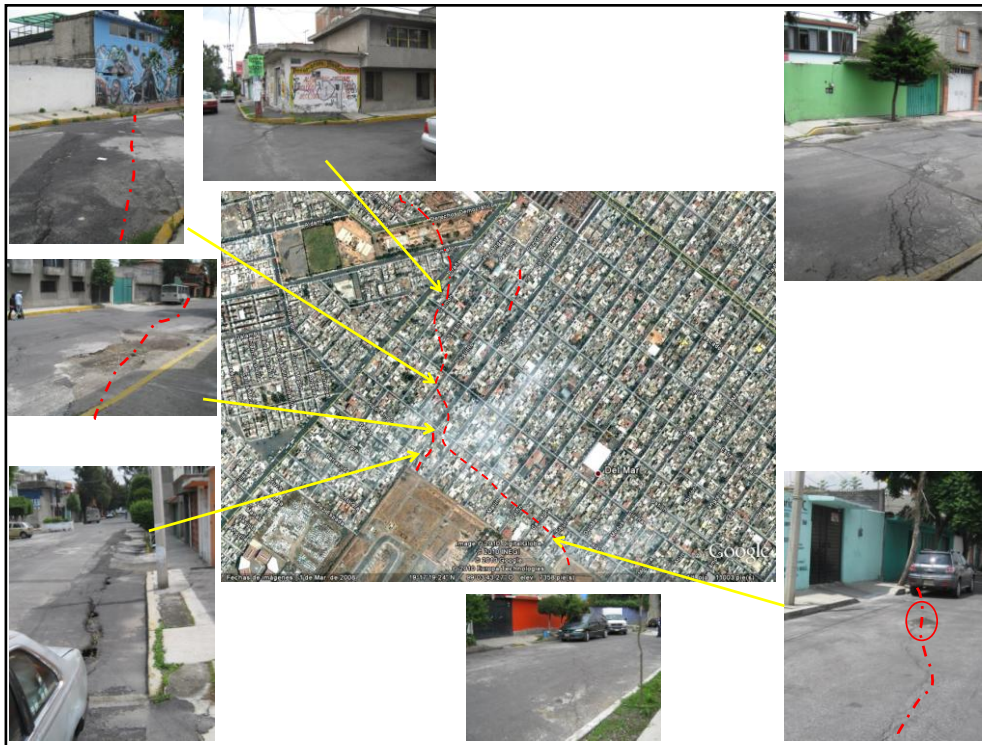
Figura 5.74.- Localización del crecimiento de las trazas del fracturamientos en el suelo, que afectan progresivamente a viviendas de la colonia del Mar, Delegación Tlhuac (2010).
