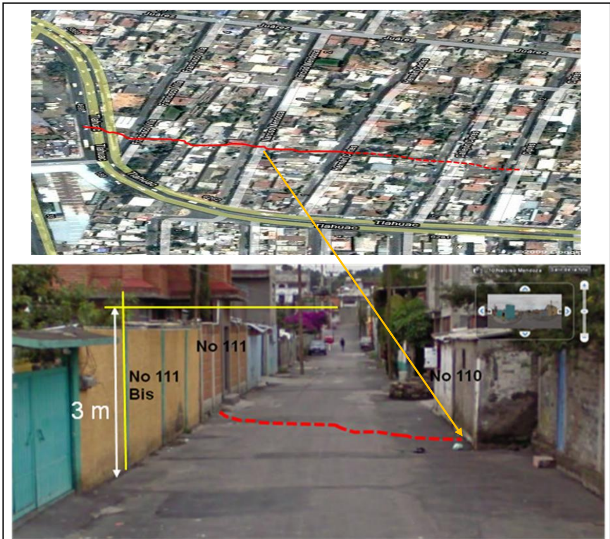
Figura 5.77.- En la imagen de satélite superior traza de grieta. Imagen inferior, Calle Narciso Mendoza con fracturamiento en dirección E-W con predios afectados (Modificado de Google, 2010).
