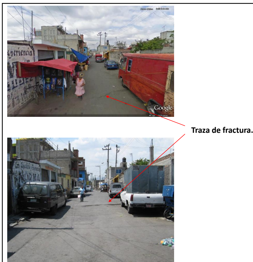
Figura 5.86.- Comparación del trazo de una fractura que cruza la calle E. Zapata. Arriba imagen del 2009 obtenida de Google, Abajo imagen del 6 de Junio del 2010, entre ambas se puede distinguir el movimiento relativo del suelo (Junio 2010).
