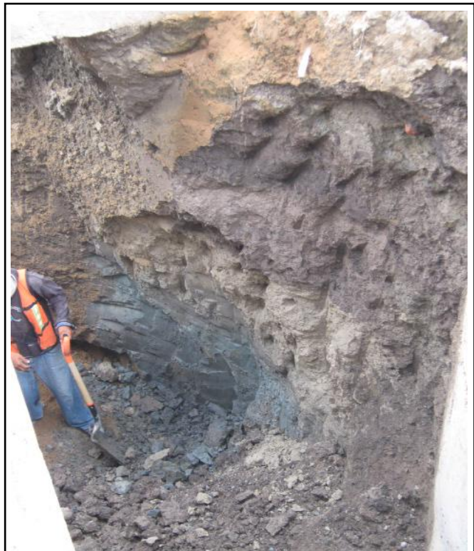
Figura. 5.31.- Fotografía que muestra la heterogeneidad en la secuencia estratigráfica, en un corte realizado dentro de la planta de bombeo "ex lienzo charro" en la Delegación Iztapalapa (Junio de 2009).
