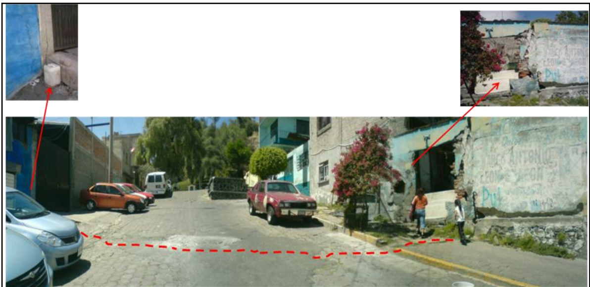
Figura 5.56.- Vista panorámica en la calle Colones y Cuernavaca donde la fractura tiene una dirección de N20°E donde también se observan puntos de control sobre todo en la vivienda No. 20, fotografía superior derecha (2010).
