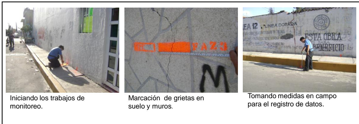
Figura 5.41.- Proceso de obtención de la información del fracturamiento en campo (Mayo, 2010).
