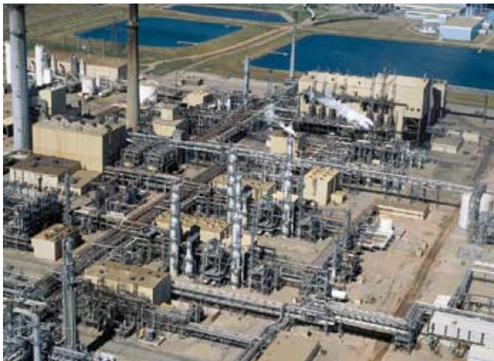
Figura 5.2 Planta de gasificación de carbón en Dakota del Norte con captura de 3.3 \text{MtCO}_2/\text{año} , usando metanol frío, proceso de disolvente físico (el grupo de 4 columnas altas, en el centro de la imagen, representan los procesos de captura de \text{H}_2\text{S} y \text{CO}_2 ; parte del flujo capturado se utiliza para la Recuperación Mejorada con almacenamiento de \text{CO}_2 en Weyburn, Saskatchewan, Canadá). (IPCC SRCCS, 2005)
