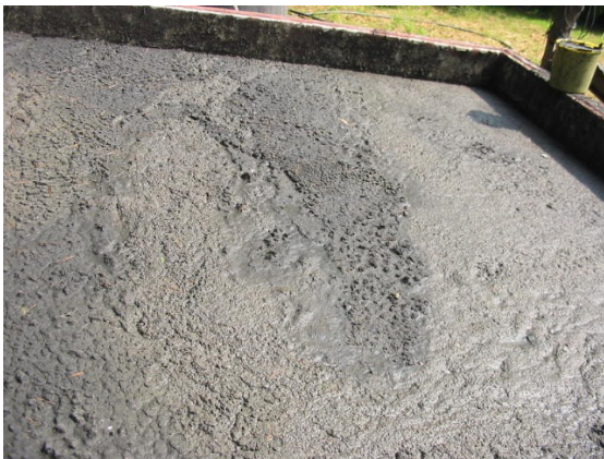
Figura 5-18. Apariencia de la nata sobre el espejo de agua del digester UASB después de retirar la lona
