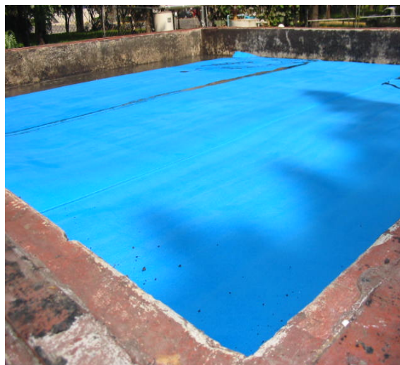
Figura 4-14. Digestor UASB con la cubierta aislante (polifom)
