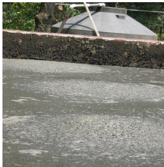
Figura 5-21. Apariencia de espejo de agua del digester UASB después de comenzar la alimentación. Se observa la formación de nata diferenciada sobre los puntos de alimentación
