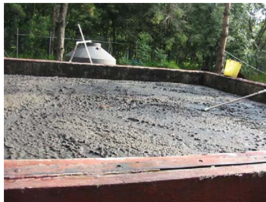
Figura 5-19. Apariencia de la nata sobre el espejo de agua del digester UASB después de retirar la lona
