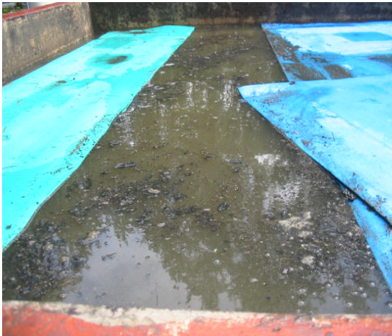
Figura 5-25. Apariencia del espejo de agua con nula formación de nata después de haber colocado las hojas de polipropileno
