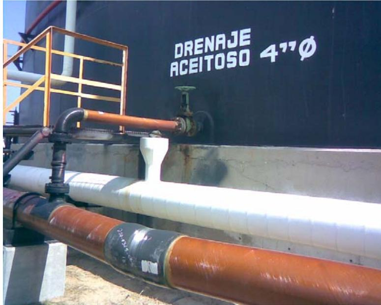
Fig.6.6. Drenaje Aceitoso (válvula y colector del mismo).
