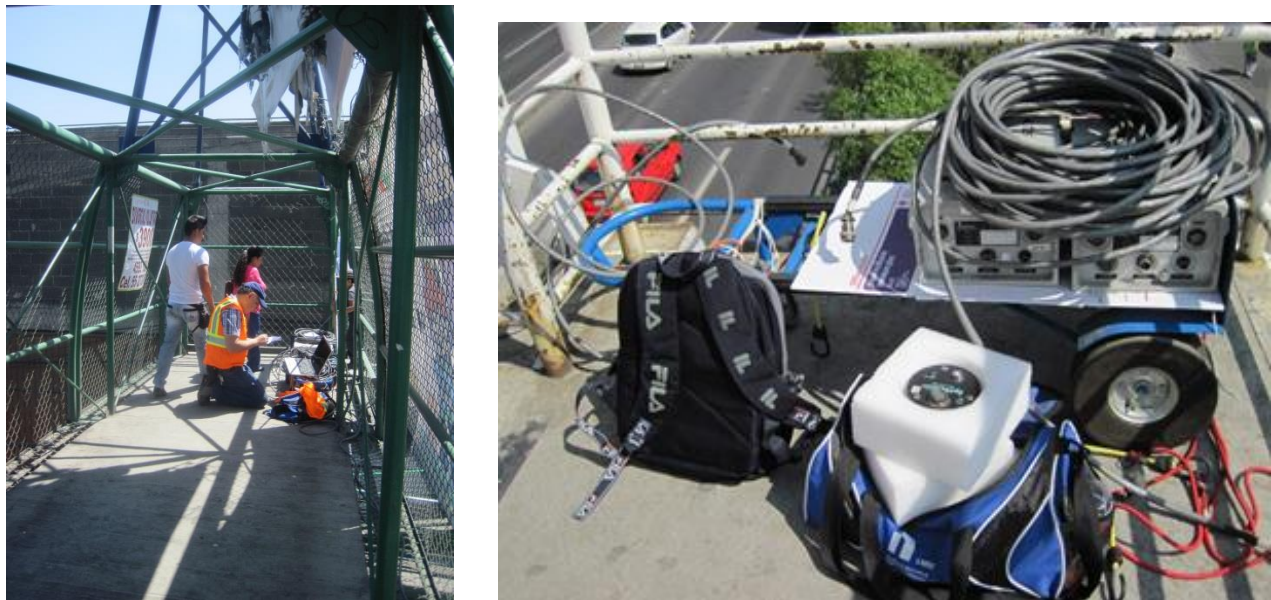
Figura 4.4 Instrumentación del puente peatonal San Bartolo mediante acelerómetros FBA ES-T, Kinematics
