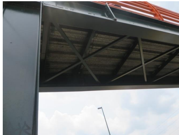
Figura 3.13 Detalle de vigas y columnas principales del puente peatonal Salamanca
