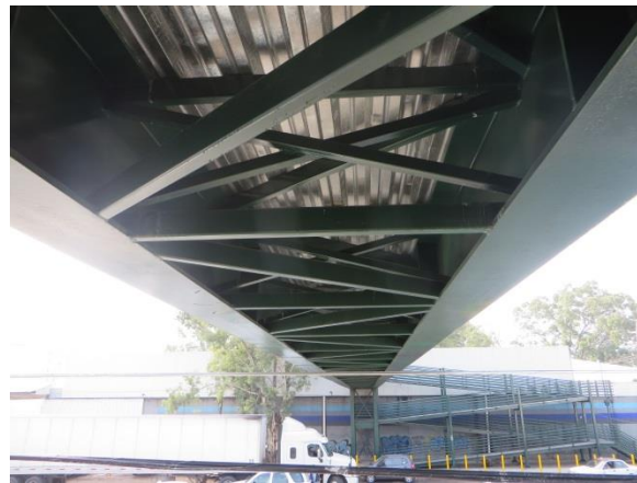
Figura 3.20 Detalle de arriostramiento por debajo del puente peatonal Pátzcuaro
