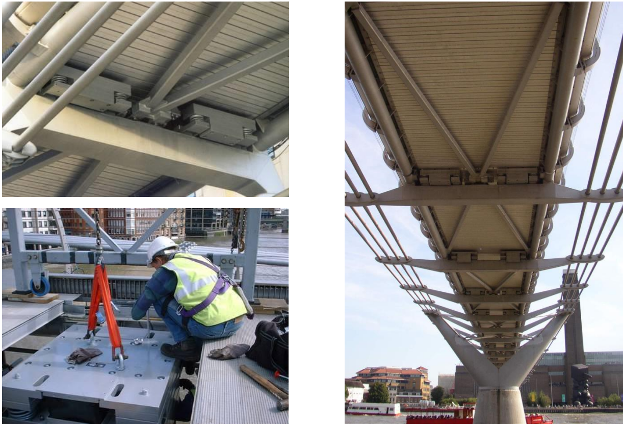
Figura 6.3 Amortiguadores de masa sintonizados (TMD) en el puente peatonal Millennium, Londres
