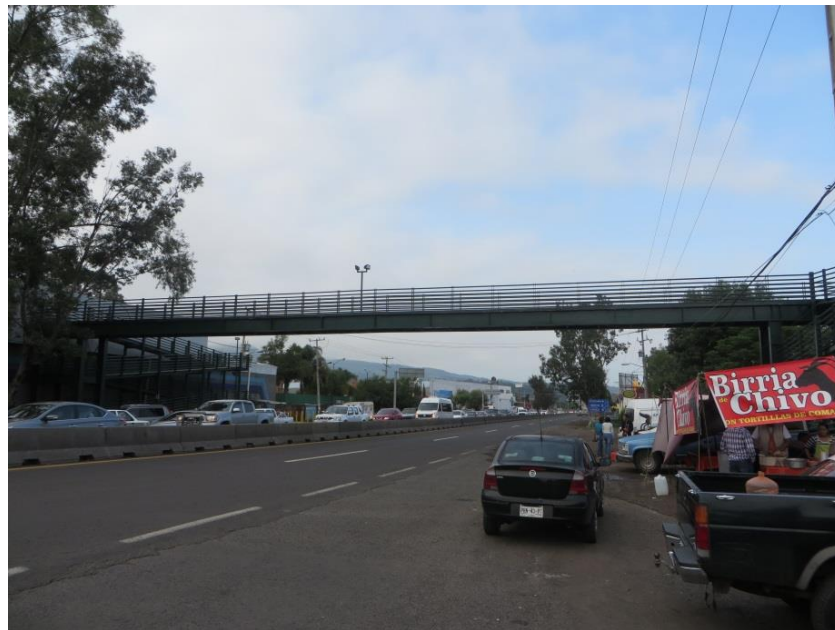
Figura 3.17 Puente peatonal Pátzcuaro, municipio de Morelia, Edo. Michoacán de Ocampo (vista general)
