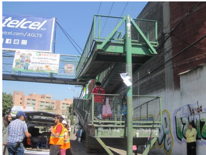
Figura 3.3 Columna estructural en rampas de acceso para el uso del puente peatonal San Bartolo
