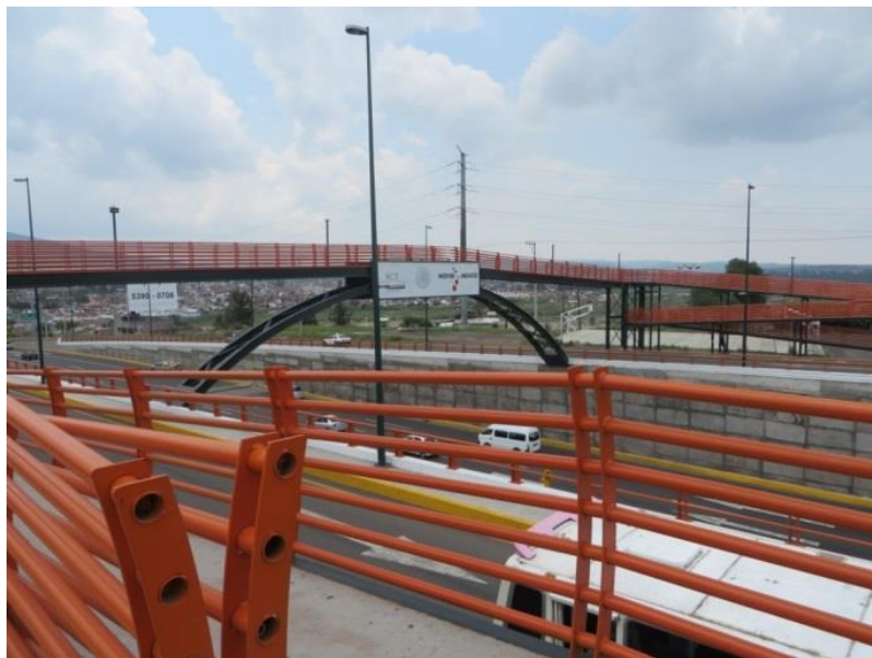
Figura 3.8 Puente peatonal Salamanca, municipio de Morelia, Edo. Michoacán de Ocampo (vista general)
