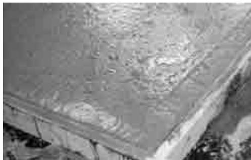
*Figura 1 Sangrado de concreto en una losa*
