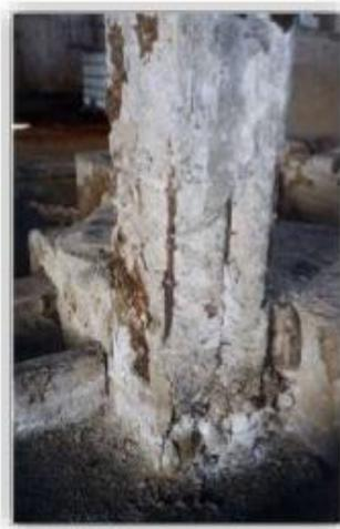
*Figura 7: Ataque por ácidos en una columna*
