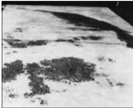
*Figura 3 Mancha en una superficie de concreto*
