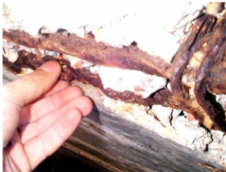
*Figura 11 Corrosión del acero de refuerzo por ataque de cloruros*
