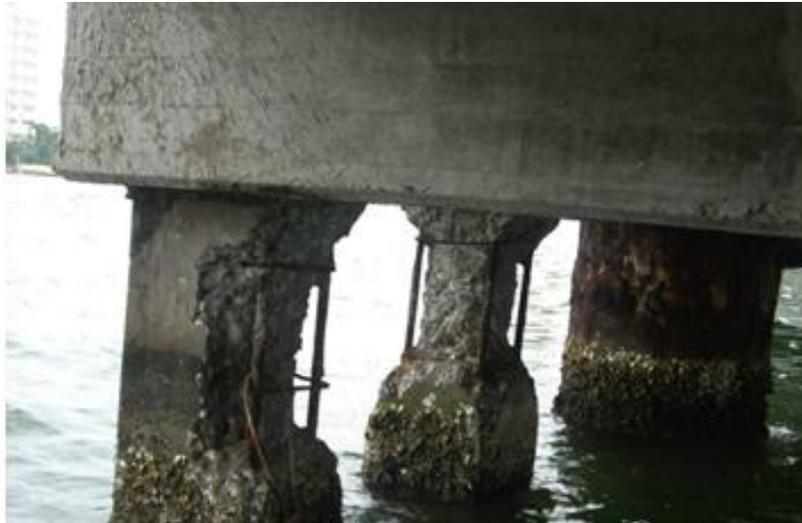
*Figura 9: Deterioro del concreto expuesto a agua de mar*
