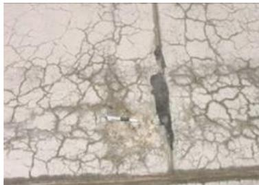
*Figura 4: Fisuras en forma de mapeo formadas por reacción álcali-agregado*
