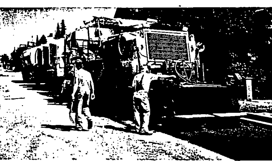
La emulsión asfáltica se utiliza para reciclar y cubrir una capa con restos de alquitrán.
