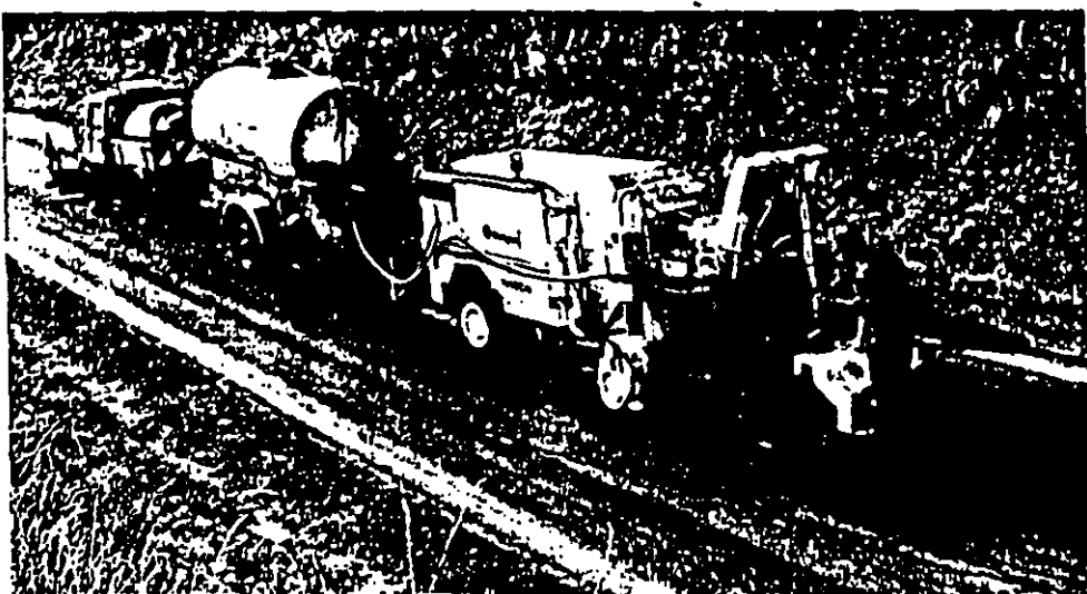
Eliminación de grietas reparando parcialmente una carretera antes de aplicar el tratamiento superficial.
