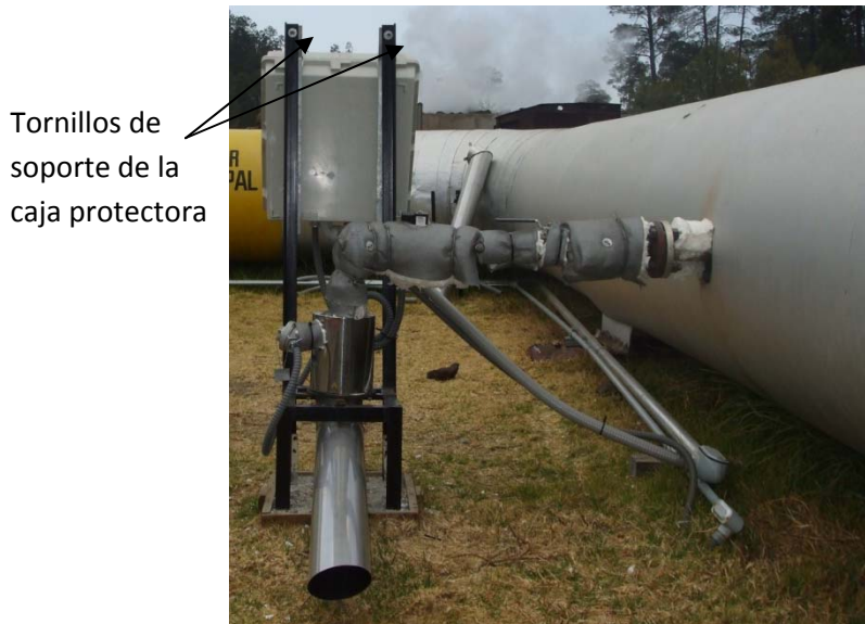
Figura 4.9 Instalación de la caja protectora
