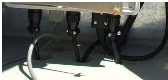
Figura 4.8 Perforaciones para el paso de los cables.
