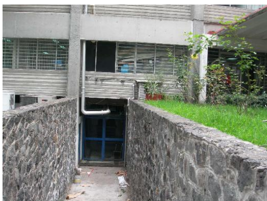
Figura 5.5 Puerta de acceso a planta de emergencia
