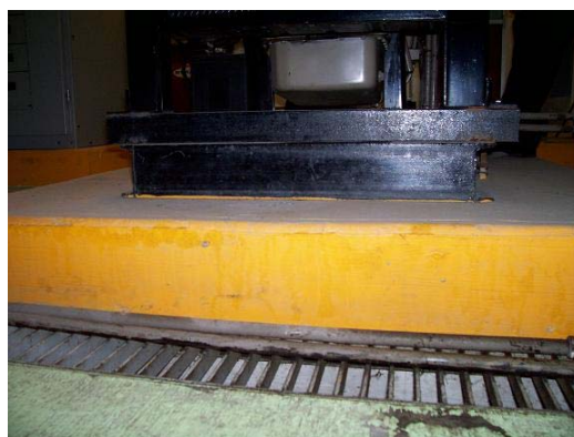
Figura 5.4 Base de concreto armado de 0.10m.
