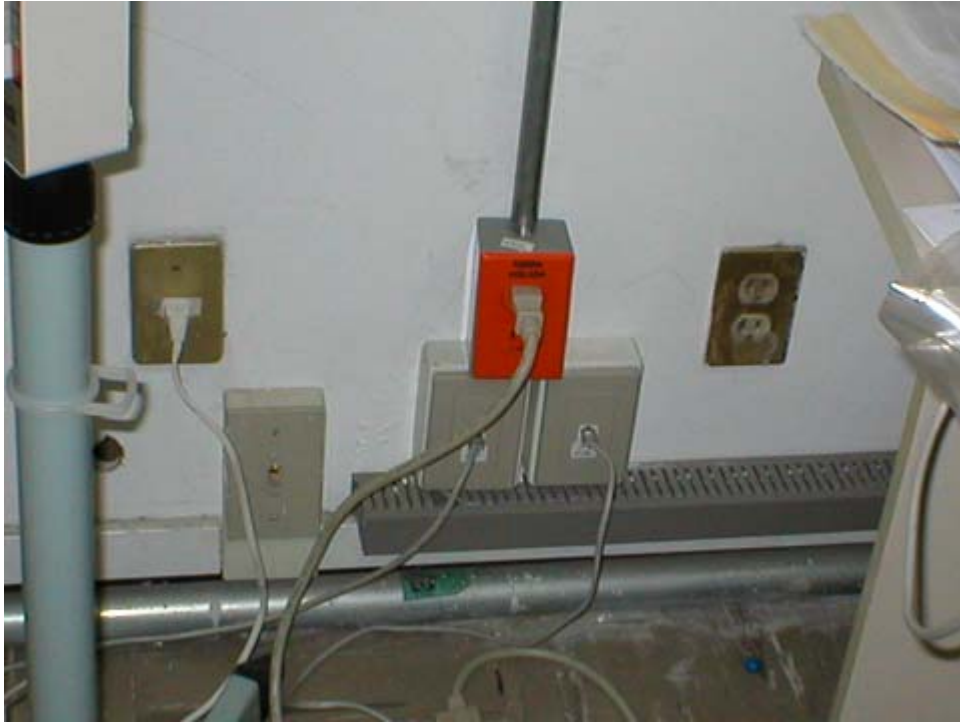
Figura 2.8 Contactos monofásicos
