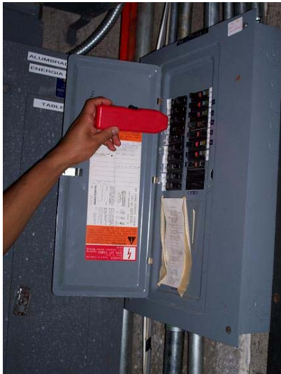
Figura 3.4 identificación de circuitos
