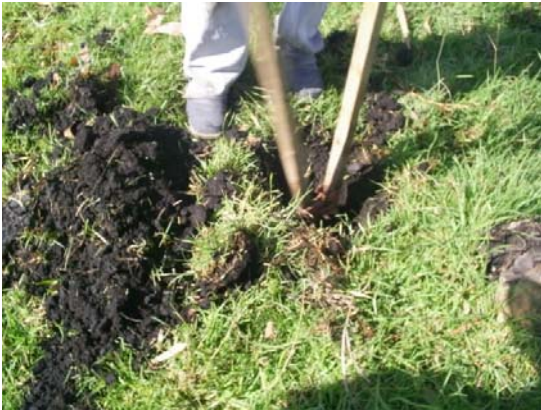
Excavación del hueco
