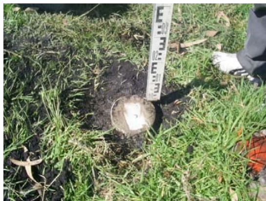
Nivelación del Banco de Nivel
