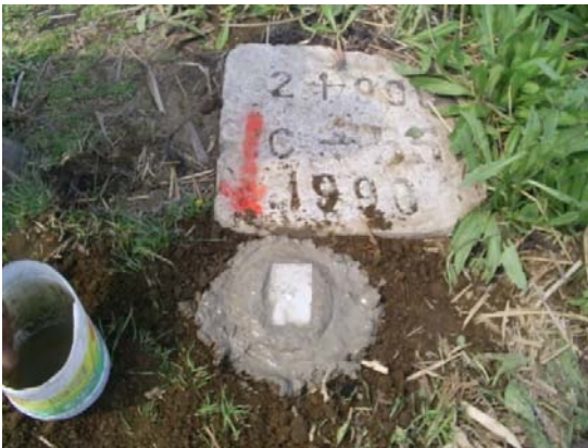
Colado del tubo
