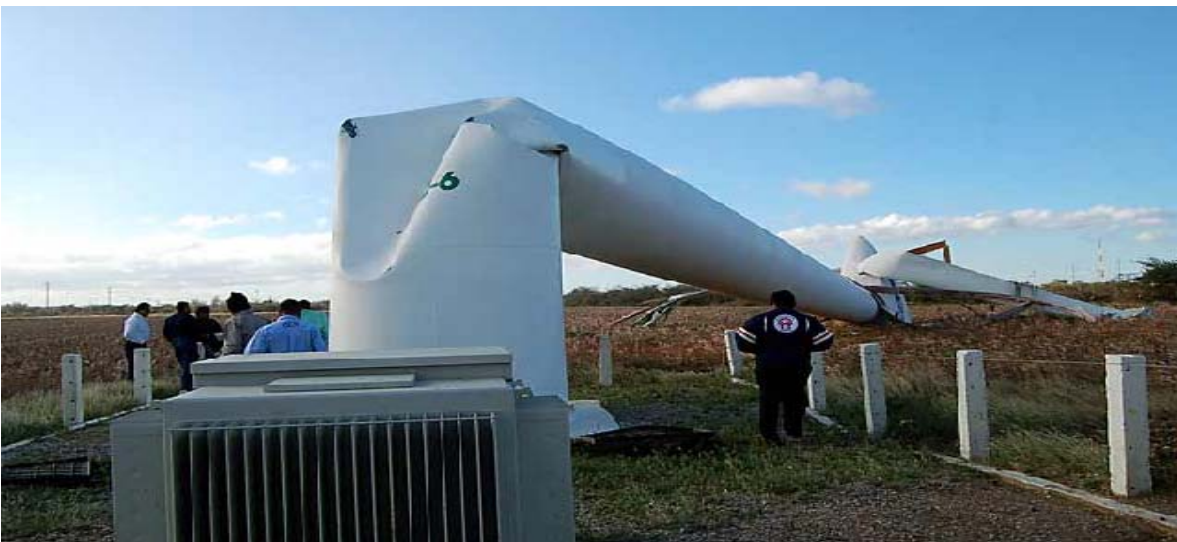
Figuras 3 y 4. La Venta , Oaxaca: aerogenerador derrumbado por vientos de más de 110 Km/h en Diciembre de 2006. 54
