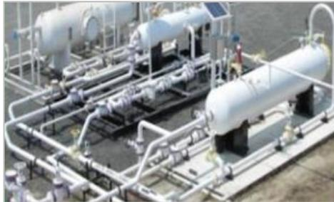
**Figura 2.8** Equipo de separación de una macropera autosustentable <sup>[30]</sup>.
