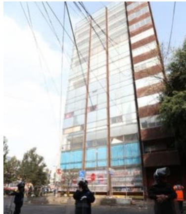
Fig. 1.25. Edificio Chapultepec 480, Roma Norte.
