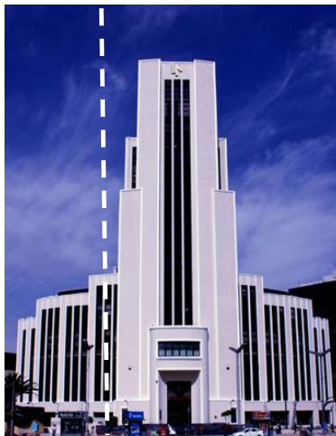
Fig. 1.5. Edificio de la Lotería Nacional. (Internet 4)
