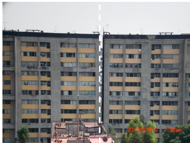
Fig. 1.24. Edificio ISSSTE 11, Tlatelolco. (Internet 8)
