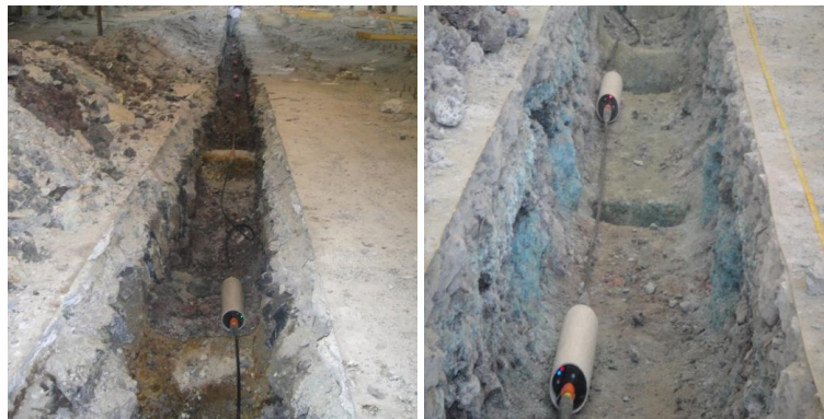
Figura 3.4. Arreglo capacitivo colocado en la zanja del perfil 1.
