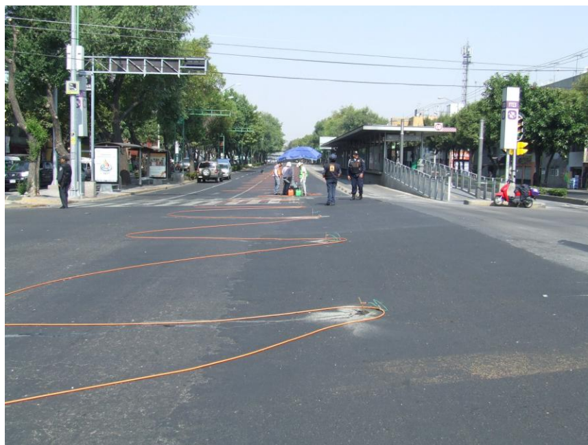
Fotografía 2. Disposición de electrodos en Línea 1, se observa la zona de bordo.
