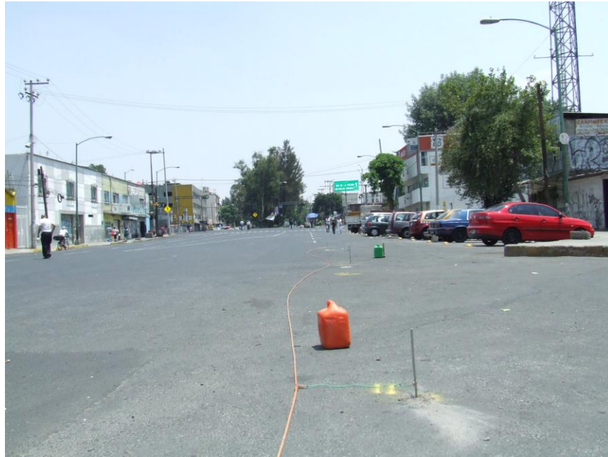
Fotografía 7. Colocación de electrodos y cable multipolar en TRE-Línea 3.
