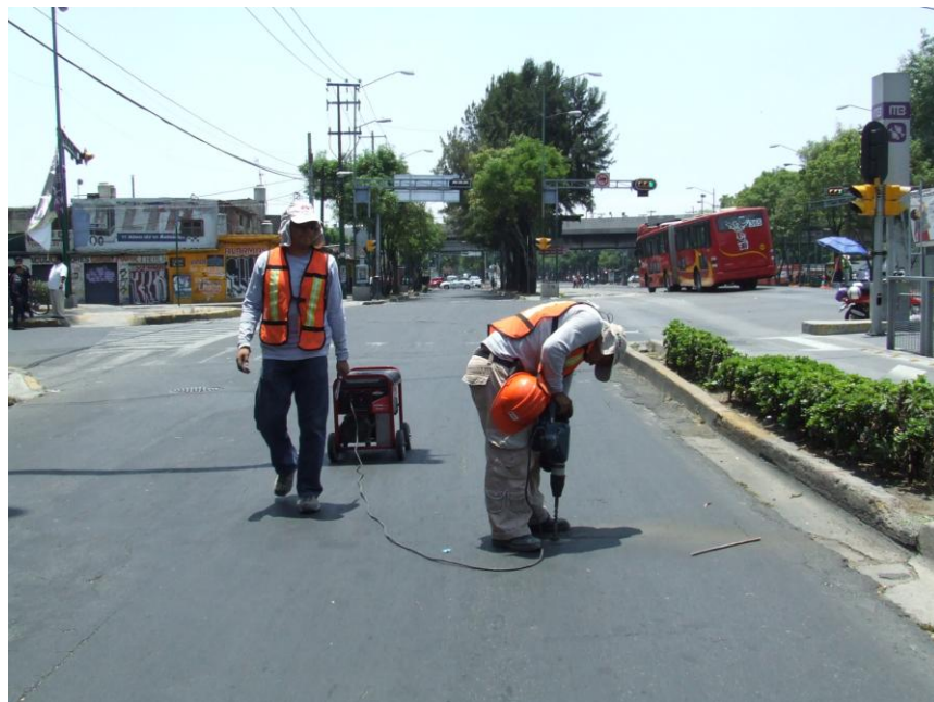
Fotografía 4. Perforaciones para inserción de electrodos.
