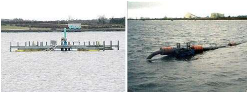
Figura1.3.- Descarga subacuática de relaves (www.tailings.info)
