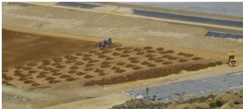
Figura1.9.- Disposición final de relaves prensados, empleando maquinaria ( www.tailings.info )
