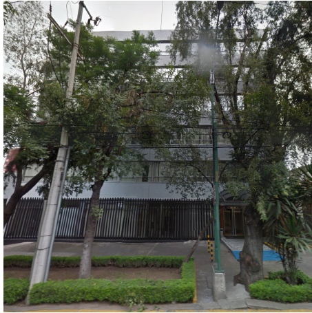
Figura 5.1. Primer caso de estudio (Edificio del SAE)
