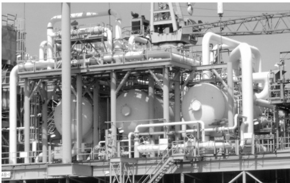
Figura 2.3. Separadores de primera y segunda etapa en un complejo de producción.
