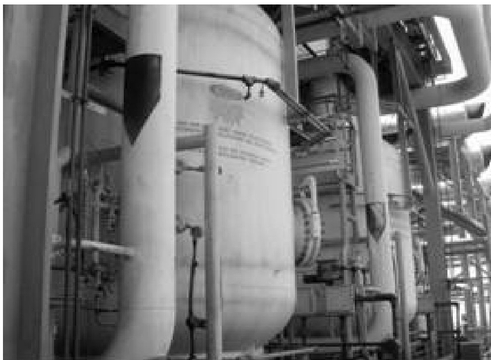
Figura 3.4. Tanques de almacenamiento de Nitrógeno.
