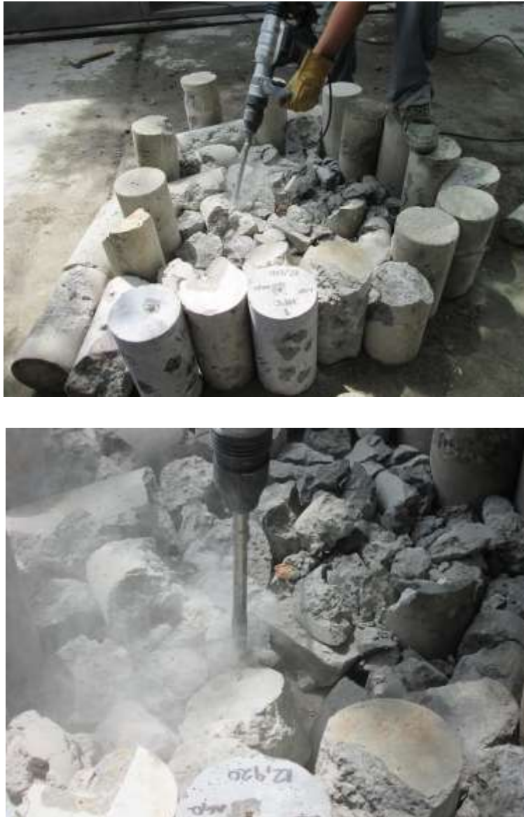
Figura 3.3.- Trituración primaria de residuos de concreto.
