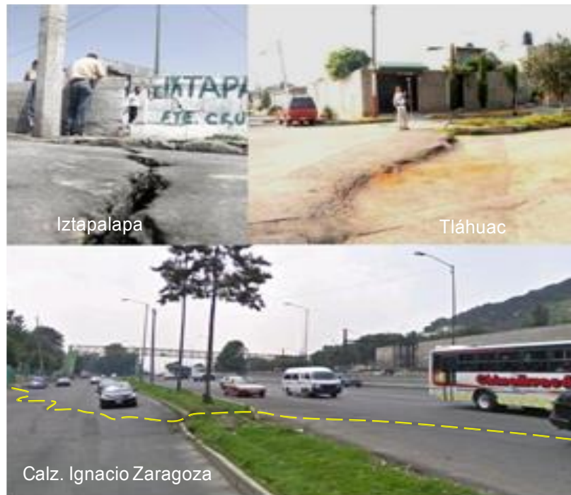
Figura 2.17 Agrietamiento en diferentes ubicaciones dentro de la zona de estudio.
