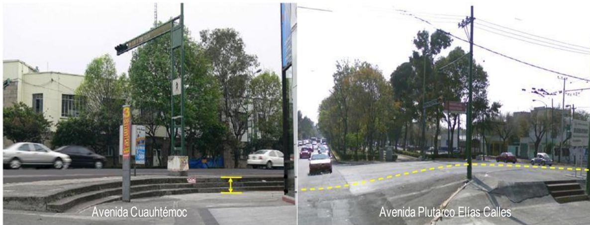
Figura 2.14 Emersión aparente debido a estructuras subyacentes.
