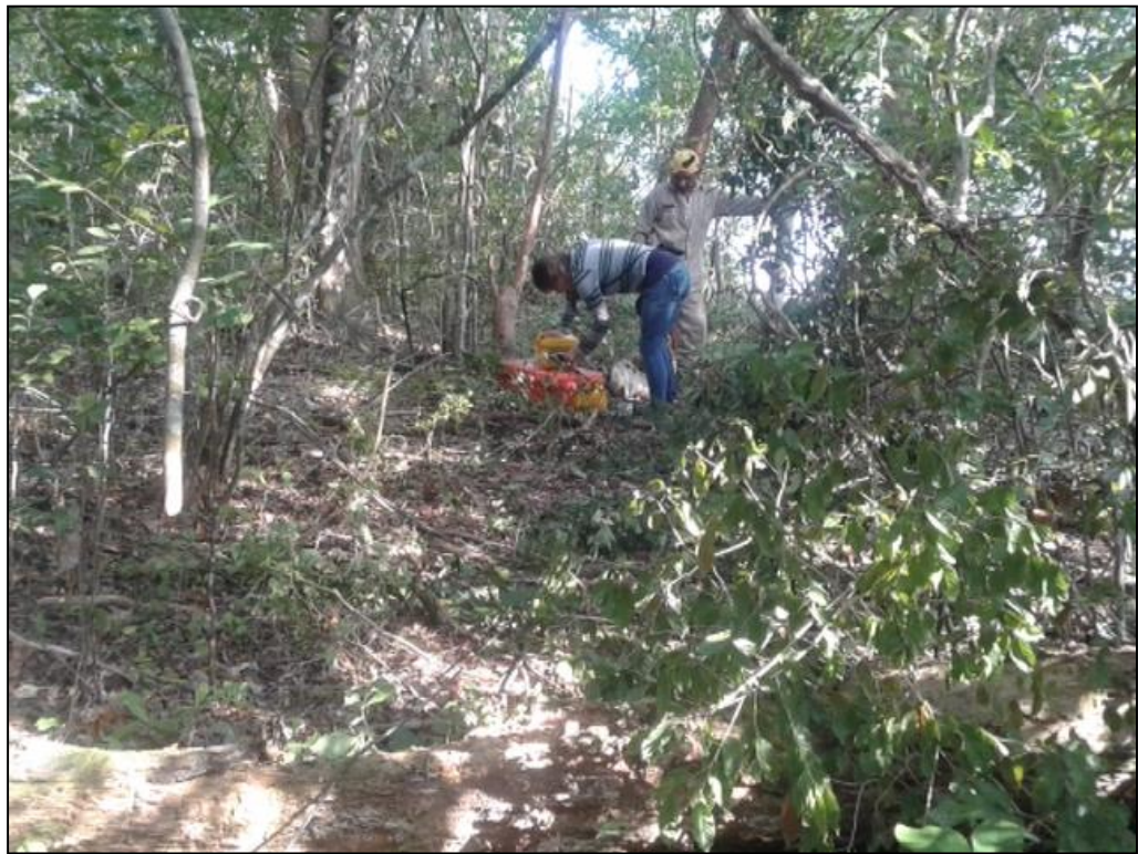
Instalación de equipo para la adquisición de TRS # PS024.
