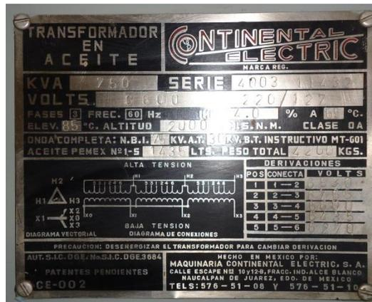
FIGURA 6.2 PLACA DE DATOS DE TRANSFORMADOR DEL EDIFICIO D DE LA FACULTAD DE QUÍMICA.
