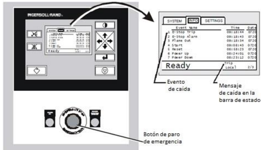
Figura 35) Botón de paro de emergencia en el panel de control y visualización en el registro de eventos (modificado de Ingersoll-Rand Energy Systems, 2002).
