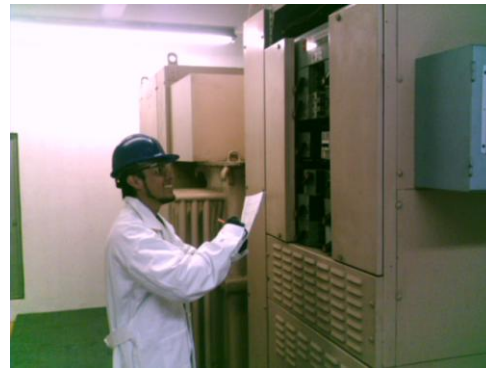
Figura 4.14 Verificación de instalaciones
