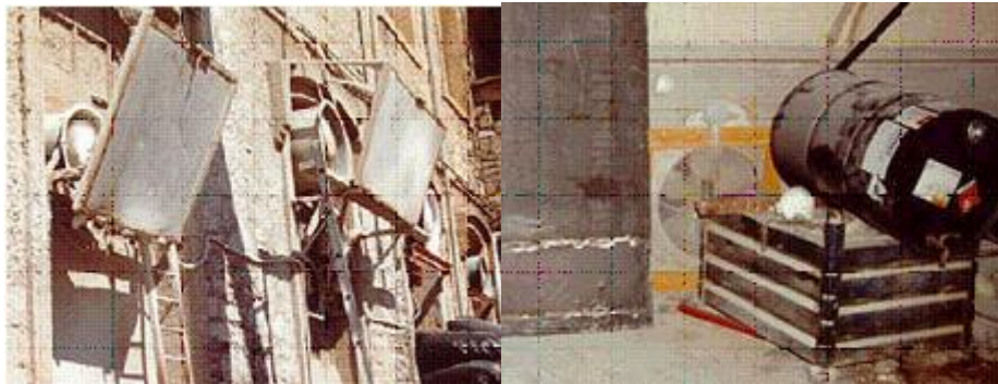
Figura 4.10 Colocación de obstáculos por delante de los ventiladores o las entradas
