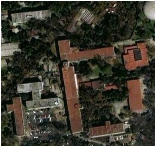
Figura 2.11 Fotografía aérea de las instalaciones bajo estudio.
