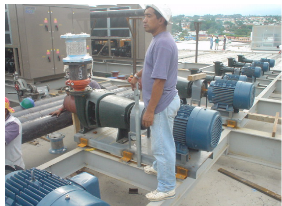
FIGURA 115. INSTALACIÓN BOMBAS DE ENFRIADORA
