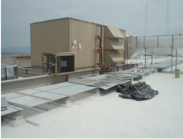
FIGURA 101. UNIDAD MANEJADORA
