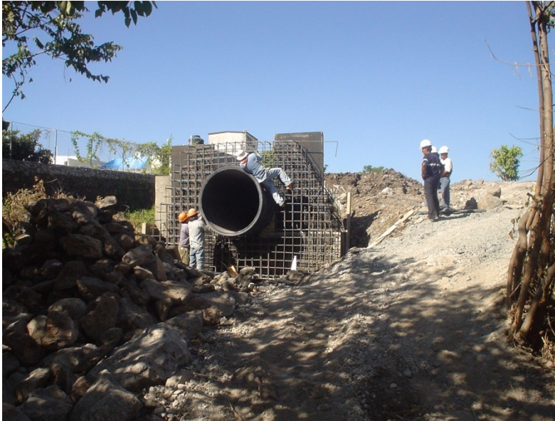
FIGURA 59. ESTRUCTURA DE SUJECCIÓN DE LA DESCARGA DEL DRENAJE PLUVIAL
