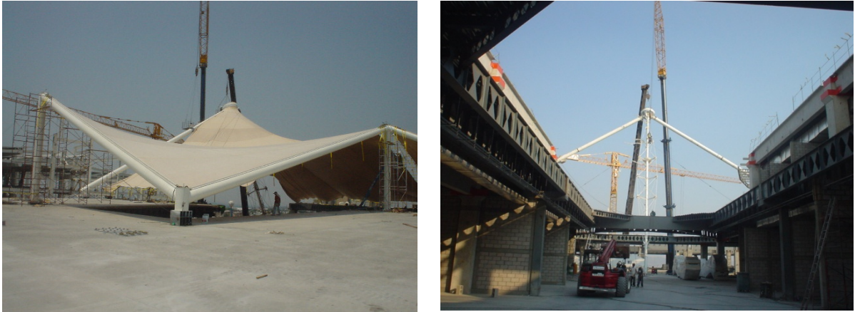
FIGURA 37. ESTRUCTURA DE APOYO DE LA LONARIA
