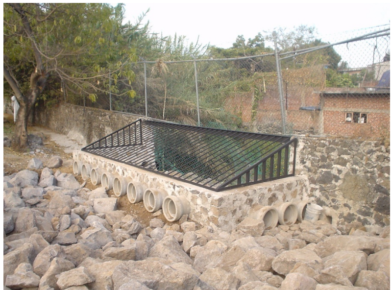
FIGURA 60. DESFOGUE DEL DRENAJE PLUVIAL AL ARROYO PUENTE BLANCO
