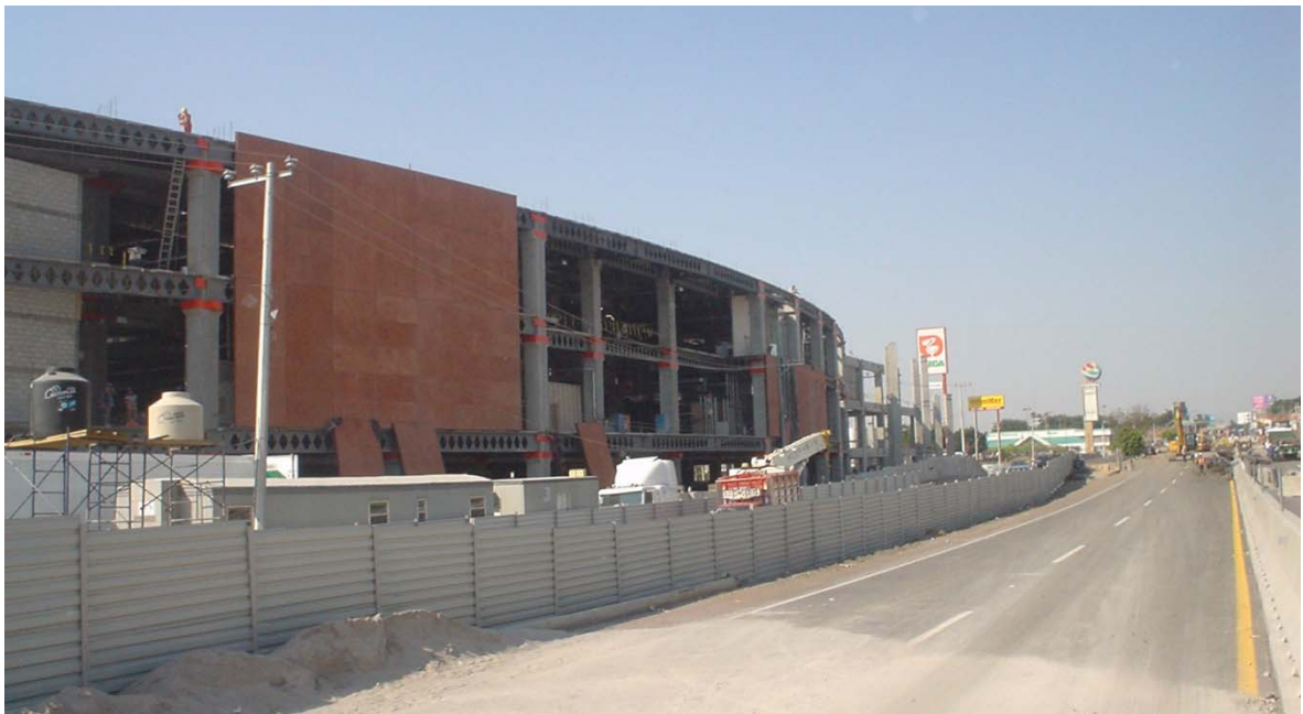
FIGURA 20. MONTAJE DE TABLEROS DE FACHADA
