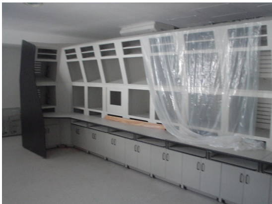
FIGURA 55. PANEL DE CONTROL EN PROCESO DE MONTAJE
