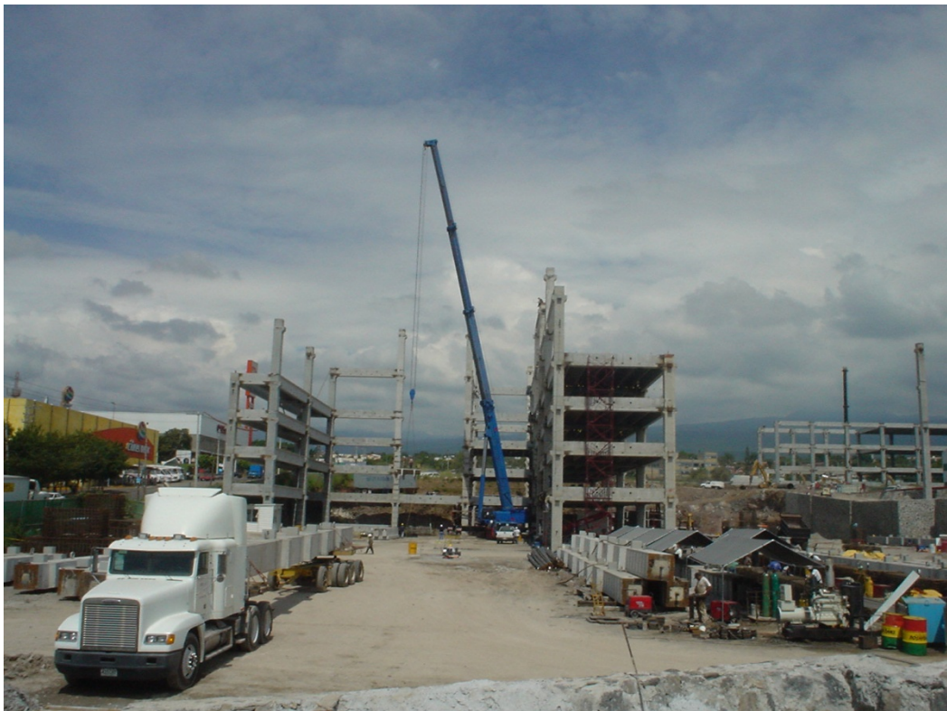
FIGURA 28. TRANSPORTE DE UNA COLUMNA CON DOLLY GRÚA DE 350 TON
