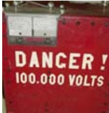
FIGURA 86. EQUIPO DE HI POT PARA PROBAR CABLES Y TRANSFORMADORES
