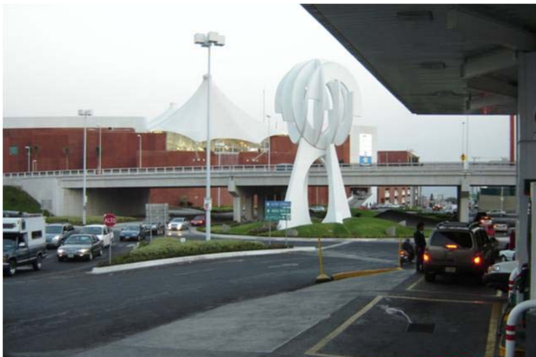
FIGURA 69. DISTRIBUIDOR VIAL TERMINADO
