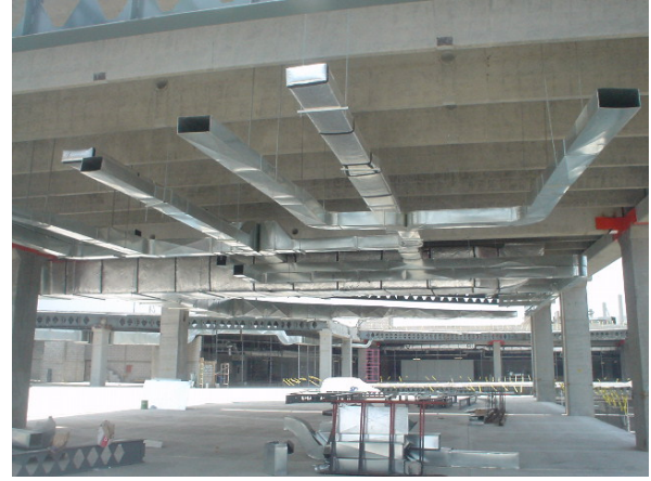
FIGURA 102. RAMALEO DE DUCTOS
