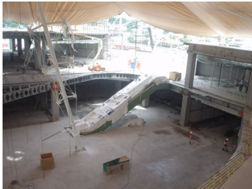
FIGURA 104. INSTALACIÓN DE ESCALERA MECÁNICA
