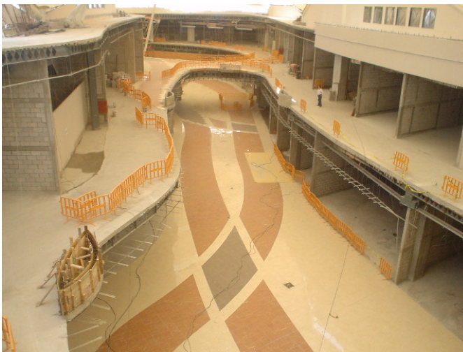
FIGURA 108. COLOCACIÓN DE PISOS
