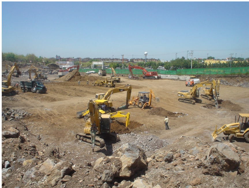
FIGURA 24. EXCAVACIÓN DE CEPAS DE ZAPATAS
