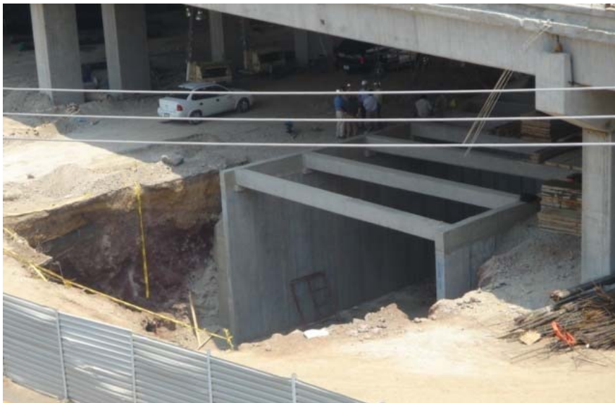
FIGURA 67. MUROS DE CONTENCIÓN TIPO SPIROLL EN EL TÚNEL
