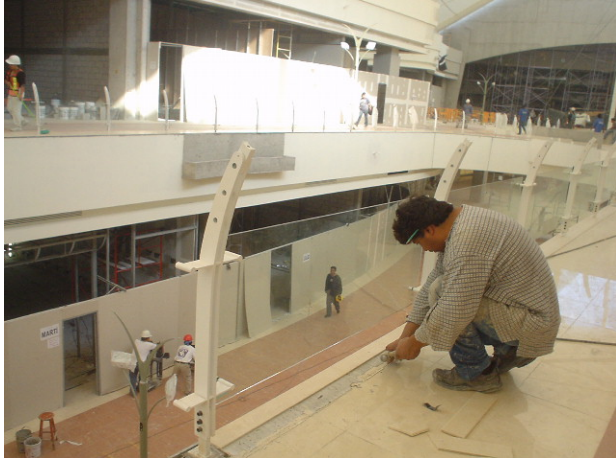
FIGURA 110. COLOCACIÓN DE BARANDAL
