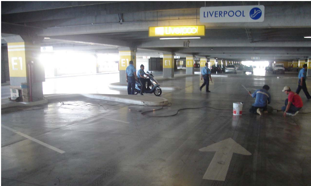
FIGURA 12. ESTACIONAMIENTO E-1 ESTRUCTURA APARENTE SEÑALAMIENTO VERTICAL Y HORIZONTAL
