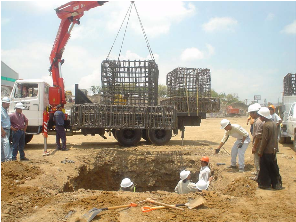
FIGURA 26. DESCARGA DEL ARMADO DE LA ZAPATA FABRICADO EN PLANTA
