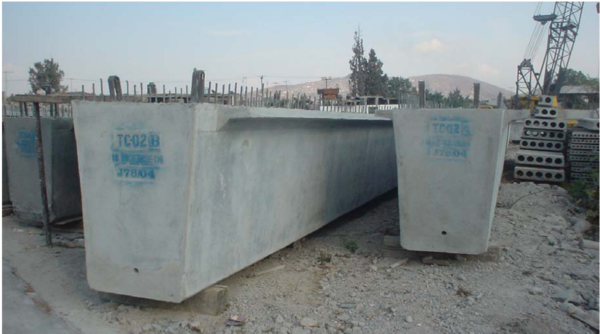
FIGURA 66. TRABES CAJÓN DEL PUENTE
