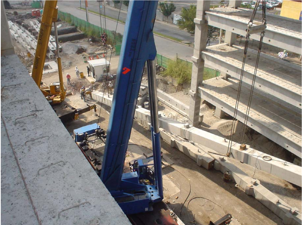
FIGURA 29. IZAMIENTO DE COLUMNA CON DOS GRÚA. LA AMARILLA EVITA EL BALANCEO
