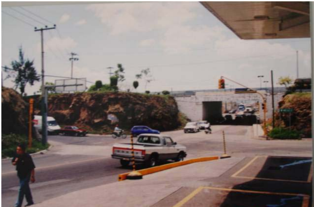
FIGURA 68. PASO INFERIOR, ANTES DEL DISTRIBUIDOR VIAL
