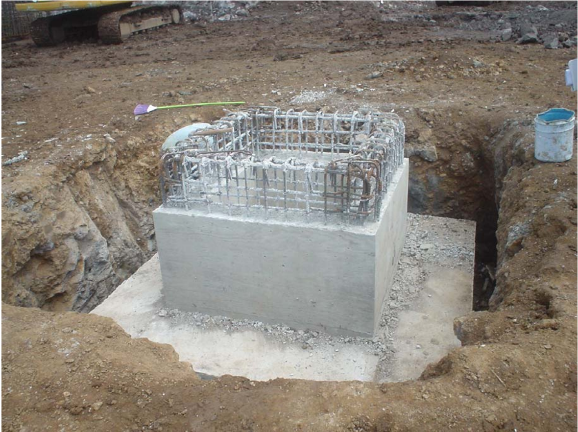
FIGURA 27. ZAPATA CANDELERO
