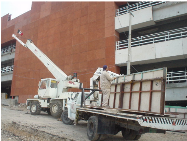
FIGURA 106. COLOCACIÓN FACHADA PREFABRICADA
