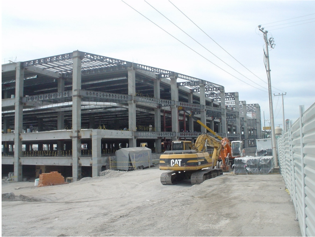
FIGURA 36. CONSTRUCCIÓN DE ÁREAS DE FORMA IRREGULAR CON ESTRUCTURA METÁLICA
